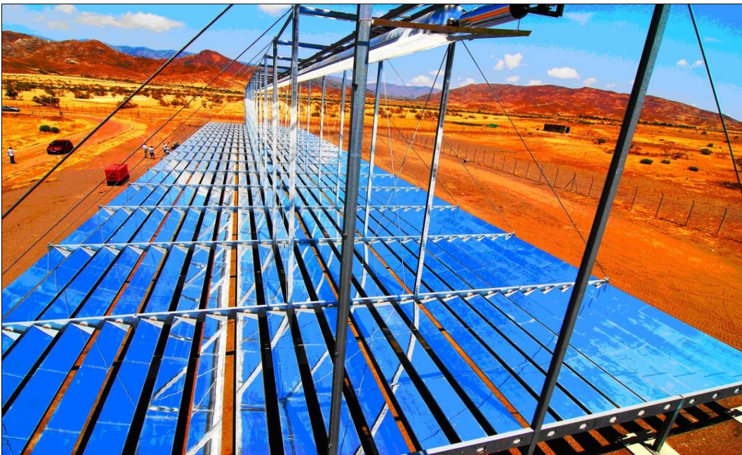
Σχήμα 2.11 Ηλιοθερμικός Σταθμός με Τεχνολογία Fresnel
