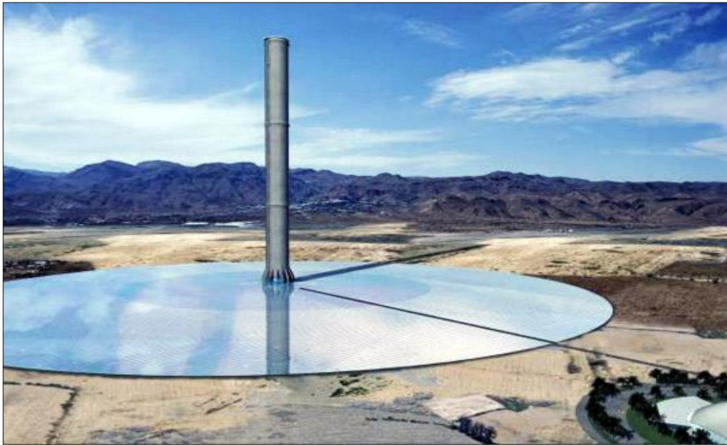
Σχήμα 2.13 Ηλιοθερμικός Σταθμός με Τεχνολογία Ηλιακής «Καμινάδας»
