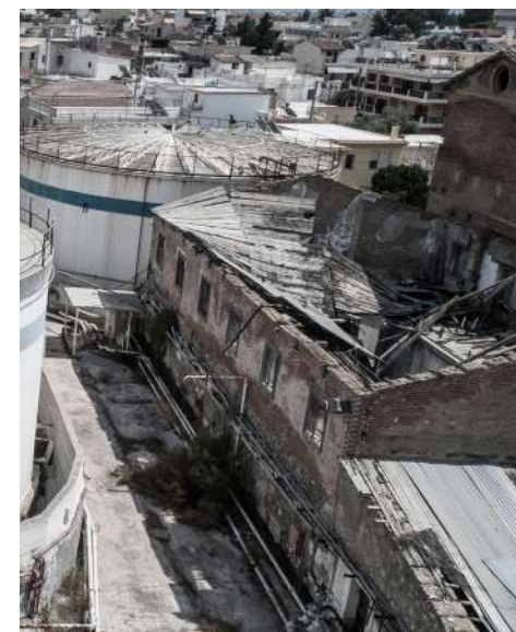
Εικ. 13, 14, 15 : Απόψεις της υφιστάμενης κατάστασης των κτιριακών αποθεμάτων του εργοστασίου Βότρυς
