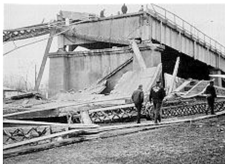
Κατάρρευση διαβρωμένης γέφυρας στο Οχάιο των Η.Π.Α. το 1967
