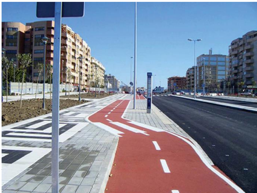
Εικόνα 5.20: Οριζόντια συναρμογή αμφίδρομου διαδρόμου ποδηλάτων στο επίπεδο του πεζοδρομίου για παράκαμψη στάσης λεωφορείου/Ισπανία (ΦΕΚ Β 1053 – 14.04.2016, 2016)
