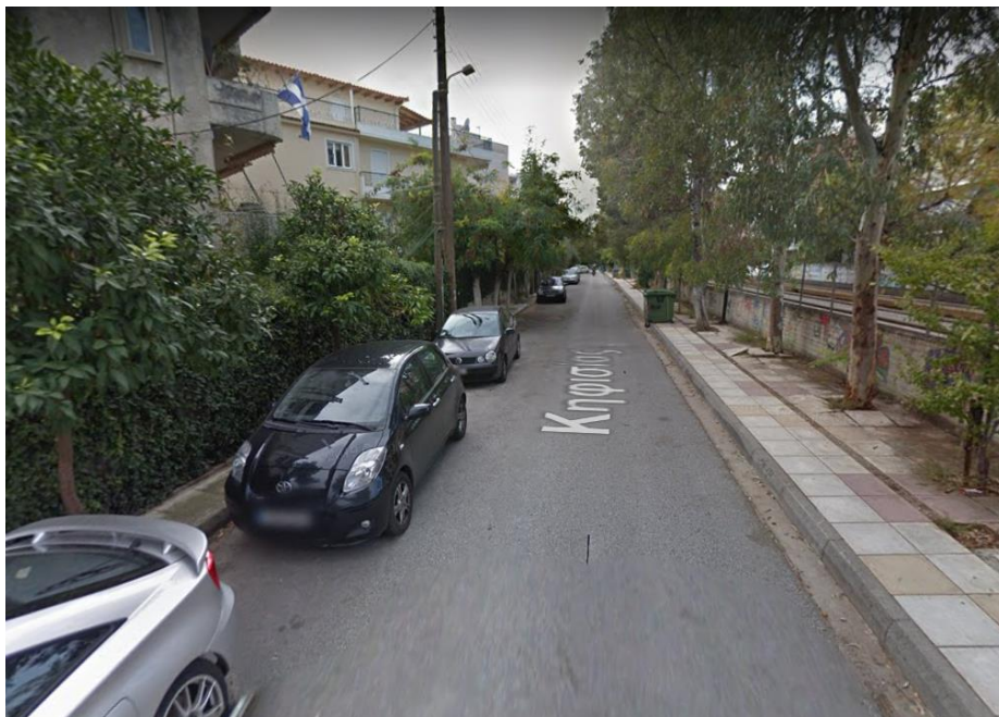
Εικόνα 5.28: Υφιστάμενη κατάσταση της οδού από google street view (έτος λήψης εικόνας 2014)
