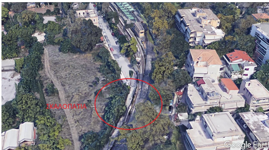
Εικόνα 5.4:Επισήμανση σκαλοπατιών στην οδό (Google Earth)
