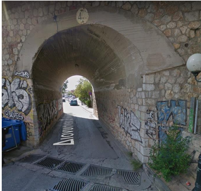
Εικόνα 5.41: Στένωση της οδού
