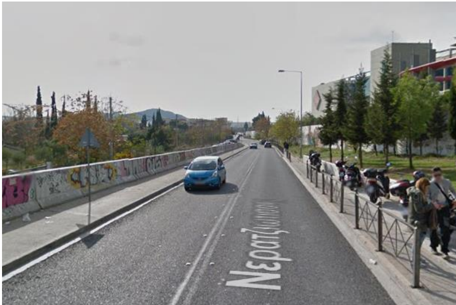
Εικόνα 5.21: Υφιστάμενη κατάσταση της οδού από google street view (έτος λήψης εικόνας 2014)
