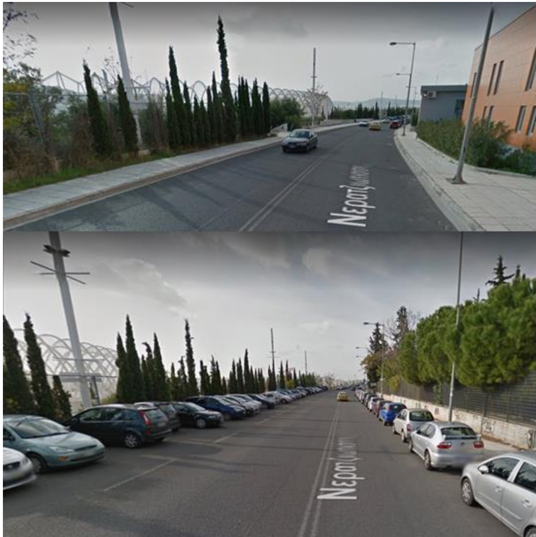
Εικόνα 5.24: Υφιστάμενη κατάσταση της οδού από google street view (έτος λήψης εικόνας 2014)
