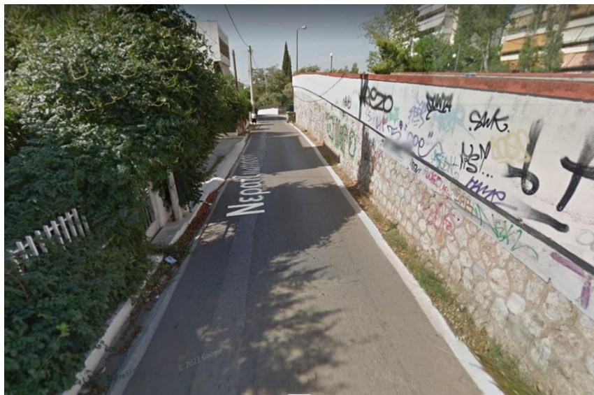
Εικόνα 5.18: Υφιστάμενη κατάσταση στο πρώτο τμήμα της οδού από google street view (έτος λήψης εικόνας 2014)
