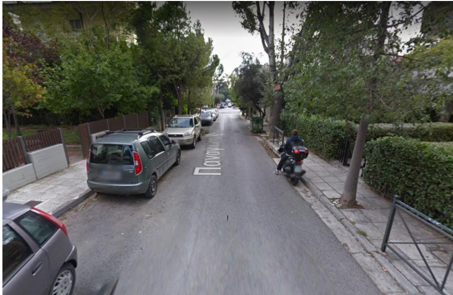
Εικόνα 5.29: Υφιστάμενη κατάσταση της οδού από google street view (έτος λήψης εικόνας 2014)
