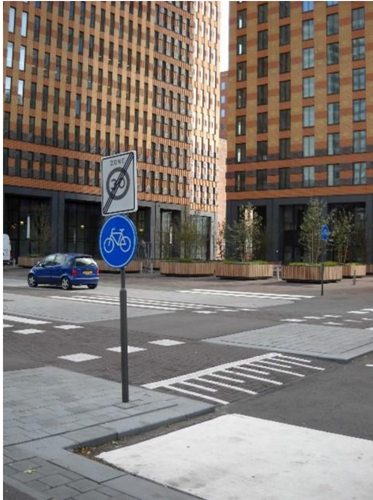
Εικόνα 5.60: Παράδειγμα ανυψωμένης διάβασης στην Ολλανδία (Μονάδα Βιώσιμης Κινητικότητας ΕΜΠ, 2021)
