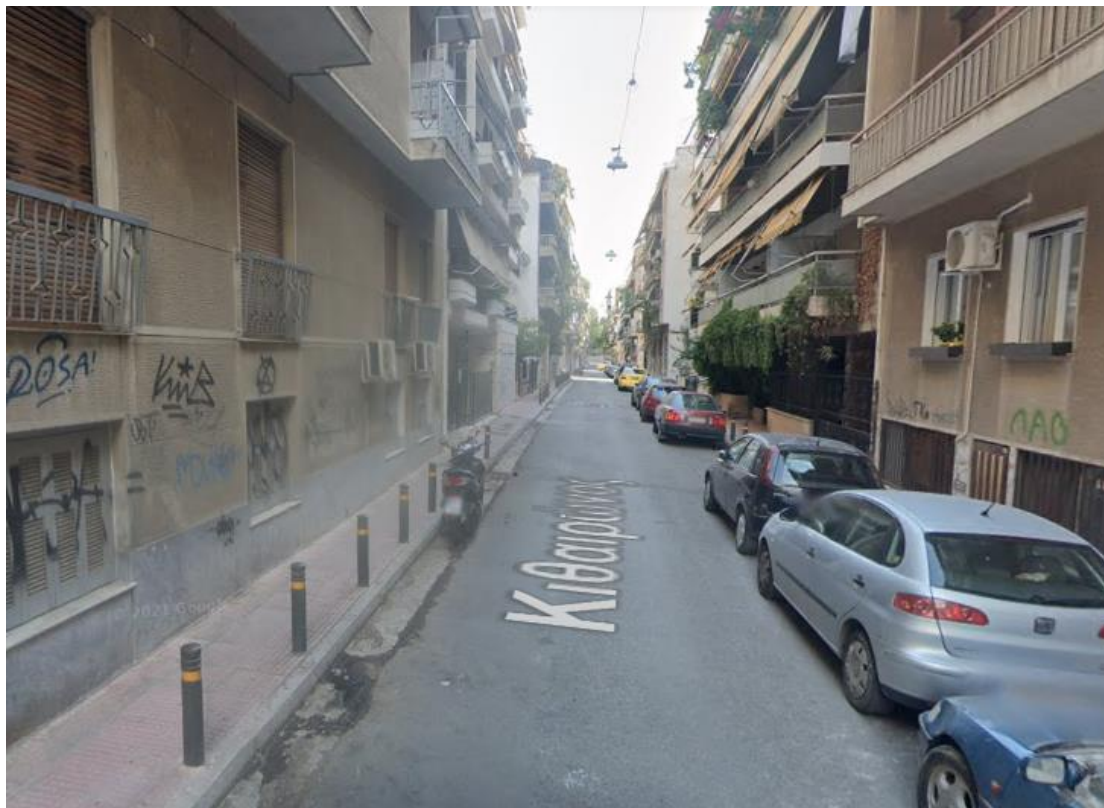
Εικόνα 5.68: Υφιστάμενη κατάσταση της οδού Κιθαιρώνος από google street view (έτος λήψης εικόνας 07/2019)
