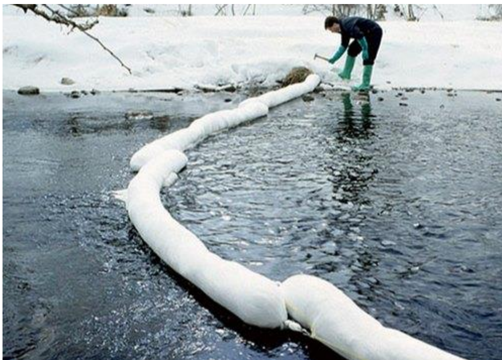
Εικόνα 1.16: Προσοφητικό υλικό σε μορφή προβόλου (boom). Πηγή: https://www.indiamart.com/proddetail/marine-sorbent-sorbent-booms-containment-booms-21362223188.html
