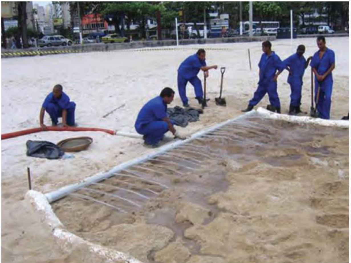
Εικόνα 4.2: Καθαρισμός άμμου που έχει έρθει σε επαφή με το πετρέλαιο με χαμηλής πίεσης έκπλυση. Τα τοιχώματα της διάταξης αποτελούνται από απορροφητικό βραχίονα για την παγίδευση του πετρελαίου. [27]
