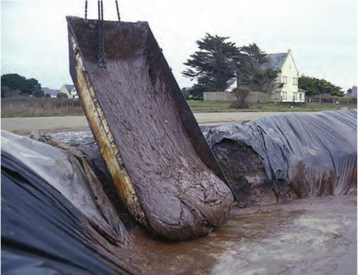
Εικόνα 4.8: Εκφόρτωση γαλακτώματος πετρελαίου από κάδο ανοιχτού τύπου (skip) εντός τάφρου ως χώρου προσωρινής αποθήκευσης.[27]
