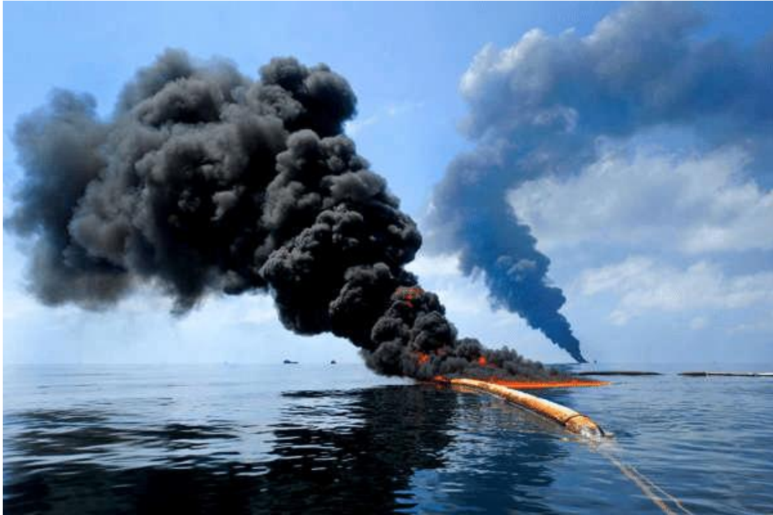
Εικόνα 1.17: Επιτόπου καύση πετρελαίου κατά την καταπολέμηση της πετρελαιοκηλίδας του ατυχήματος που συνέβη το 2010 στον κόλπο του Μεξικού. Πηγή: https://www.researchgate.net/figure/Controlled-in-situ-burning-in-the-Gulf-of-Mexico-after-containing-the-oil-with-a-fire_fig8_344402983
