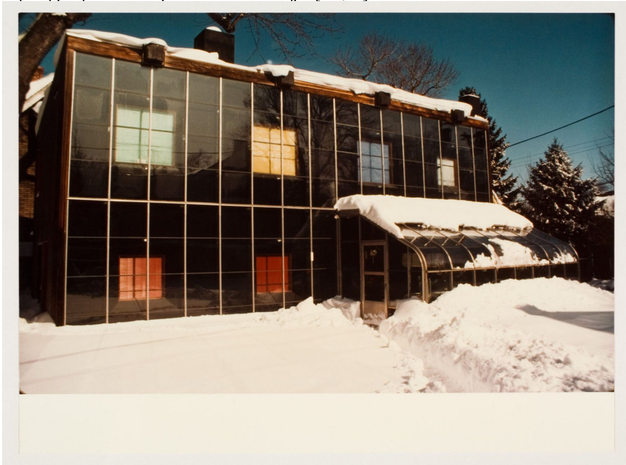
11Εικόνα 1.2.6: Γενική άποψη νότια πλευράς κτιρίου Kelbaugh
