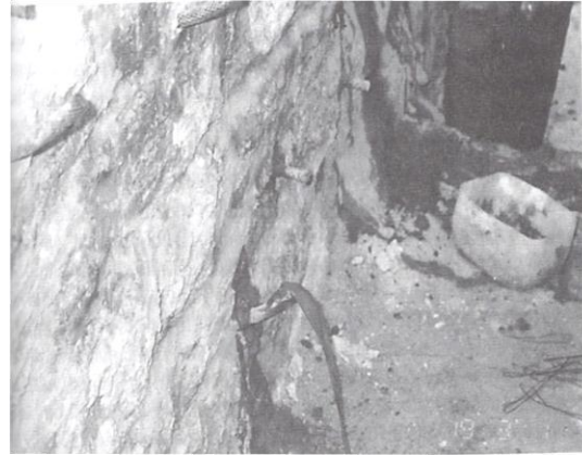
Φώτο. 5.3.4: Ένεμα εξερχόμενο από σωληνίσκο [6]
