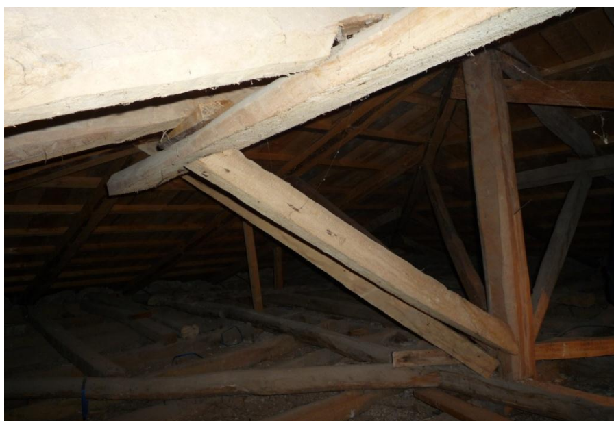
Φώτο 2.2.4: Στέγη κτιρίου
