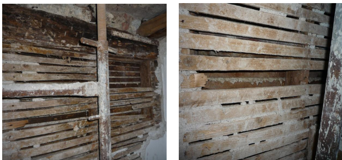
Φώτο 2.2.2: Εσωτερικό ξυλόπηκτων τοίχων
