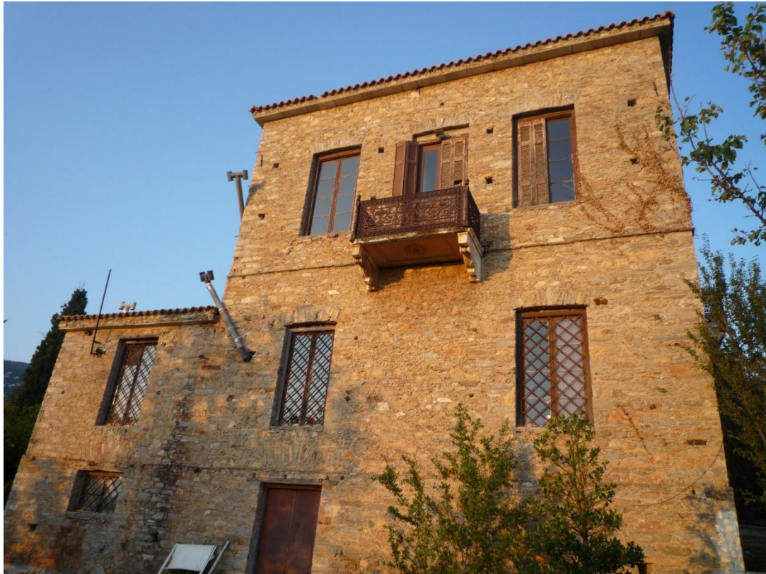
Φώτο 2.1.2: Πλάγια όψη κτιρίου
