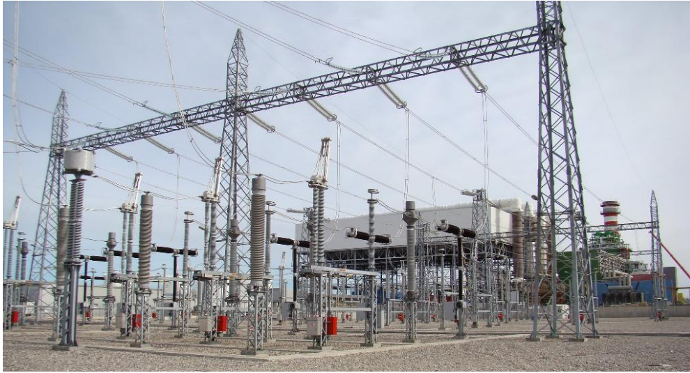
Εικόνα 15. Υποσταθμός 400/150kV
