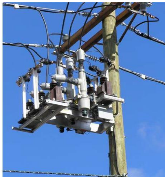
Εικόνα 44. Μονοπολικό Δ/ΑΕ (αριστερά) και τριπολικό Δ/ΑΕ με δυνατότητα μονοπολικής πτώσης και επαναφοράς (δεξιά) [20]
