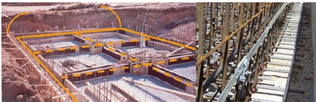
Εικόνα 77. Εφαρμογή θεμελιακής γείωσης σε κτιριακή εγκατάσταση
