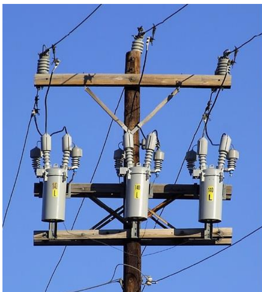
Εικόνα 44. Μονοπολικό Δ/ΑΕ (αριστερά) και τριπολικό Δ/ΑΕ με δυνατότητα μονοπολικής πτώσης και επαναφοράς (δεξιά) [20]
