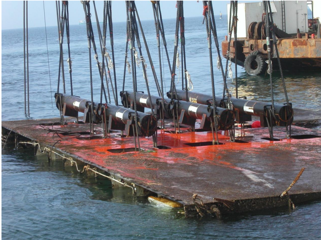
Σχήμα 5.23: Στη φωτογραφία φαίνεται ο τρόπος πρόσδεσης του shear leg σε ένα από τα κομμάτια καθώς αυτό βγαίνει από την επιφάνεια της θάλασσας (48).
