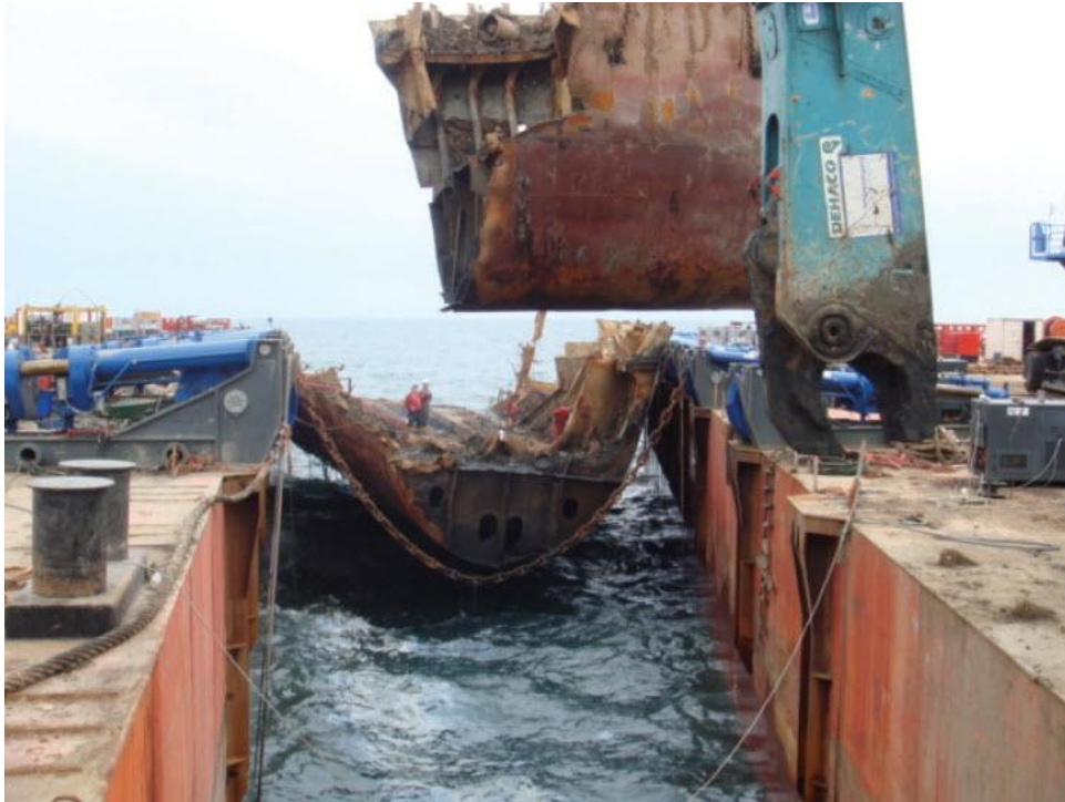
Σχήμα 5.18: Τα διάφορα κομμάτια που προέκυπταν από την διάλυση με την βοήθεια γερανών τοποθετούνταν επάνω στις πλωτές εξέδρες (42).
