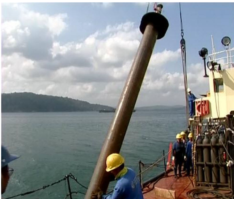
Σχήμα 5.27: Η μία από της 12 κατασκευές που αποτελούνται από τα καπάκια, τους σωλήνες και τις βάνες (52).
