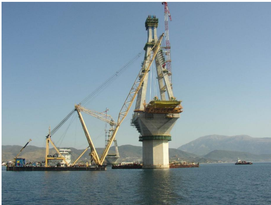
Σχήμα 4.22: Το shear leg Taklift 7, της εταιρίας SMIT, χρησιμοποιήθηκε στην κατασκευή της γέφυρας Ρίου-Αντιρρίου (32).
