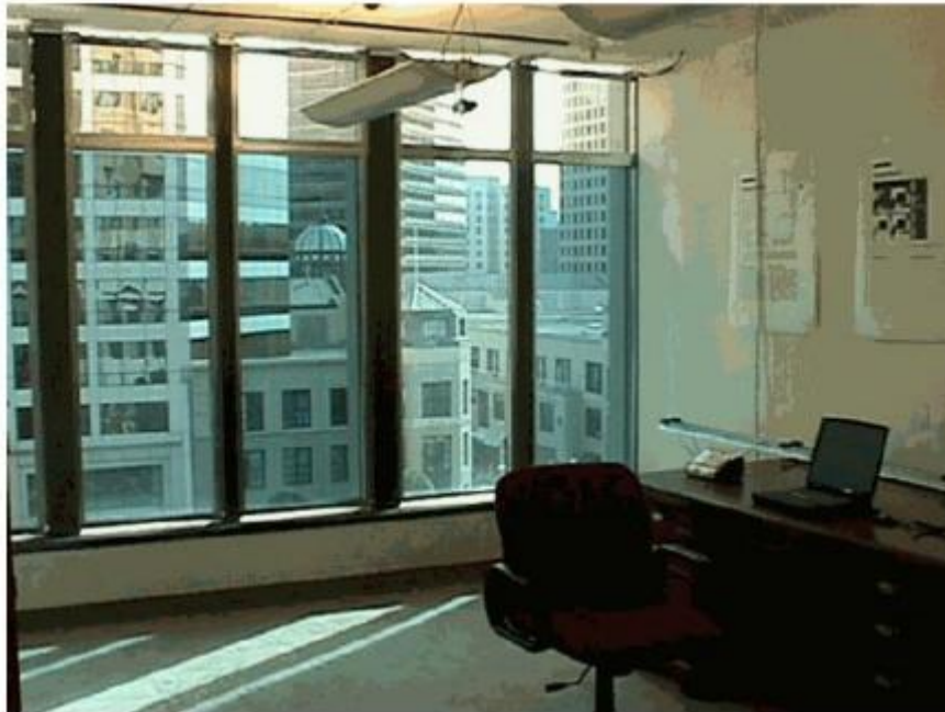
Εικόνα 3-8 Εφαρμογή των ηλεκτροχρωμικών παραθύρων E-Control της Pilkington σε κτίριο γραφείων
