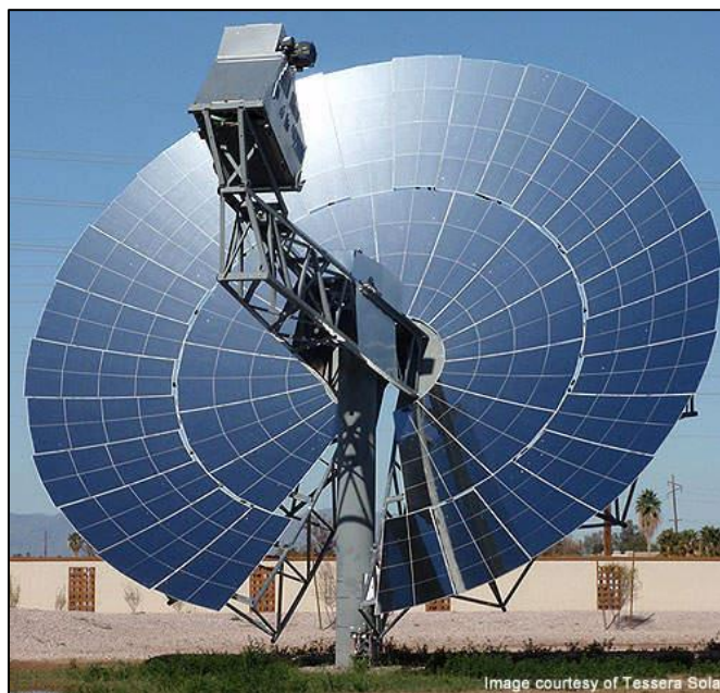
Εικόνα 1.13: Ηλιακός συλλέκτης παραβολικού δίσκου. [17]
