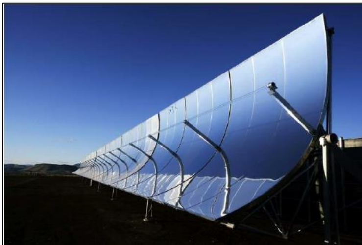
Εικόνα 1.9: Συλλέκτης παραβολικού κατόπτρου. [12]
