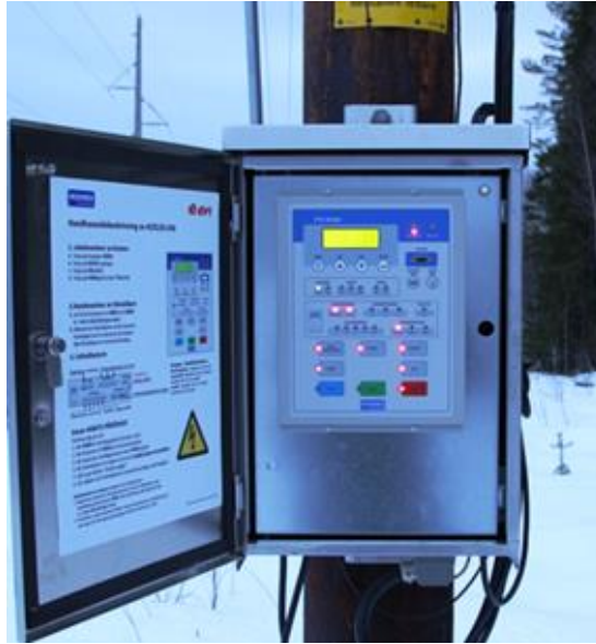
Σχήμα 2.5: Απομακρυσμένος Ελεγκτής ενός ΔΑΕ
