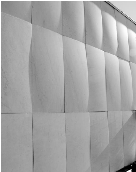
Εικόνα 5: Παράδειγμα κυρτωμένων πλακών μαρμάρου
