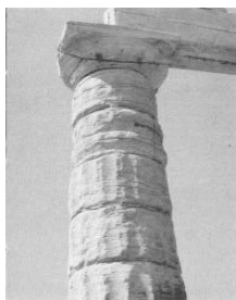
Εικόνα 2.4: Αιολική διάβρωση και μηχανικές τάσεις. Ναός του Ποσειδώνα, Σούνιο.
