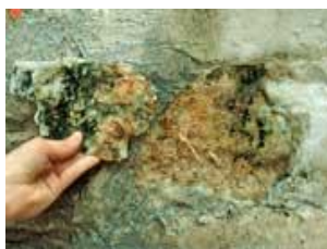
Εικόνα 2.5: Βιολογική φθορά.
