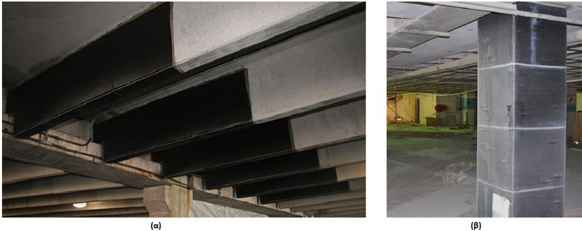
Εικόνα 6.1 : Υφάσματα FRP για την ενίσχυση (α) δοκών και (β) υποστυλωμάτων
