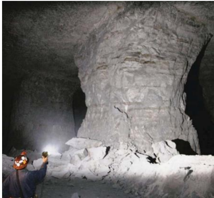
Εικόνα 2.3.2.1: Χαρακτηριστικό σχήμα κλεψύδρας που υποδεικνύει υπερφόρτιση στύλου έπειτα από benching (Esterhuizen et al., 2011)
