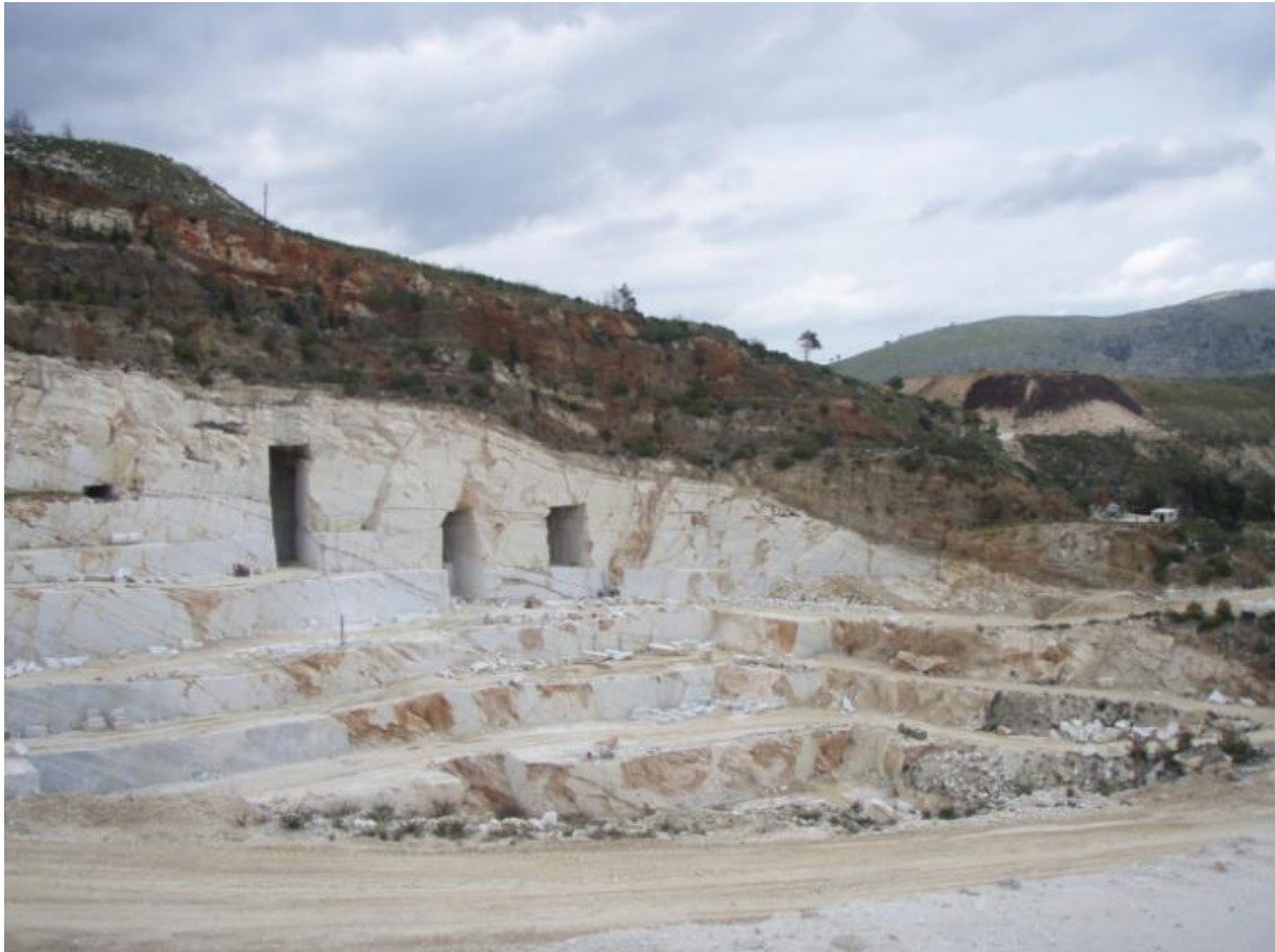
Εικόνα 1.4.2.1: Προσπάθεια υπόγειας εκμετάλλευσης μαρμάρου στις αρχές της δεκαετίας του '90, Διονυσοβούνι Αττικής (Dionyssomarble SA)
