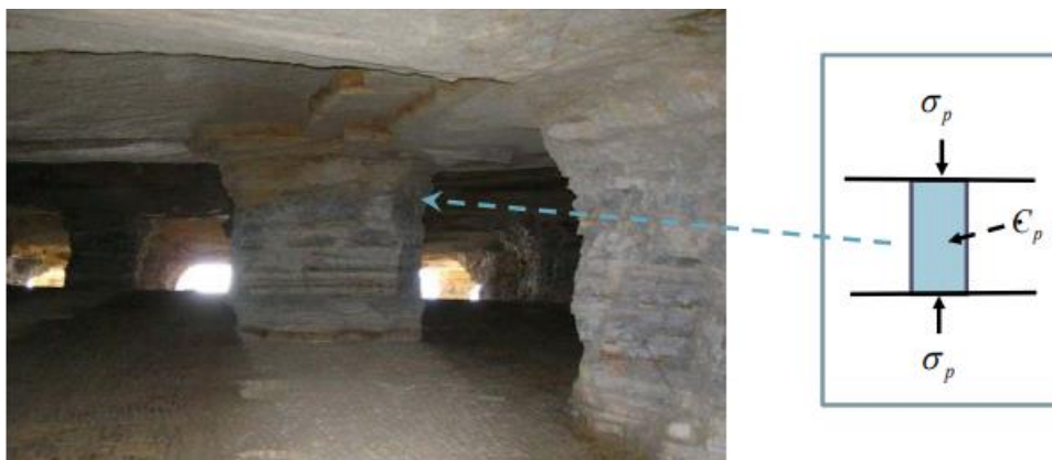
Σχήμα 2.3.1.1: Φόρτιση στύλων από την τάση των υπερκείμενων πετρωμάτων (Μπενάρδος και Καλλιαμπάκος, 2010)
