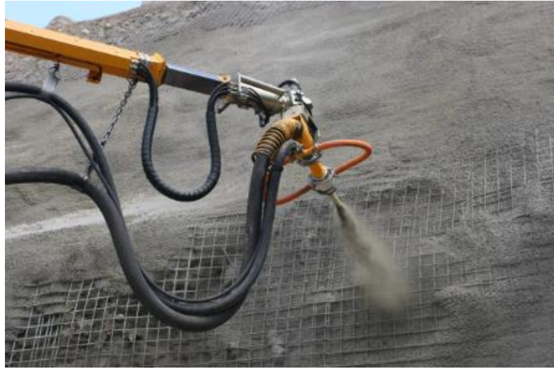
Εικόνα 2.26: Εφαρμογή εκτοξευόμενου σκυροδέματος με δομικό πλέγμα ( https://mys.sika.com/en/knowledge-hub/sprayed-concrete.html )
