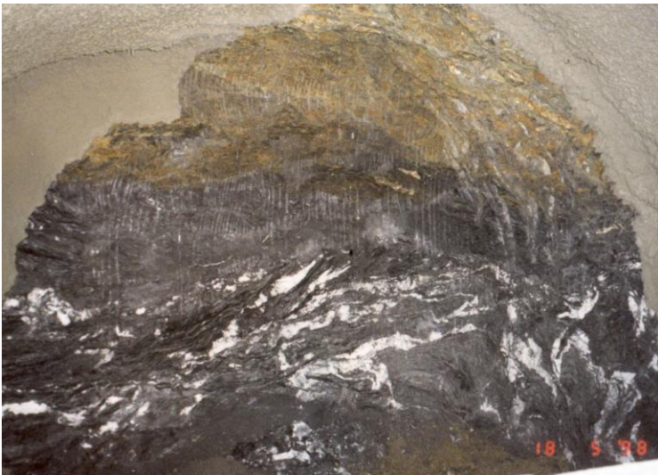
Εικόνα 3.14: Επαφή γκριζοπράσινου μεταψαμμίτη Ανώτερου «Αθηναϊκού Σχιστόλιθου» (άνω μέρος όψης σήραγγας) με μαύρο γκρίζο αργιλικό σχιστόλιθο του Κατώτερου «Αθηναϊκού Σχιστόλιθου». Σημειώστε τους άφθονους, λευκούς, πτυχωμένους, χαλαζιακούς φακούς του κάτω μέρους του σχιστόλιθου. Μέτωπο εκσκαφής σήραγγας μονής τροχιάς (~ 6 μ.) – Γραμμή 3, Διασταύρωση «Μοναστηράκι» - «Κεραμικός». (Boronkay, K. et all, 2021)
