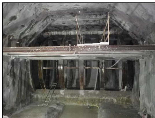
Εικόνα 52. Διατομή σήραγγας NATM, μετά την ολοκλήρωση της προσωρινής υποστήριξης. (Πηγή Άκτωρ ΑΕ)
