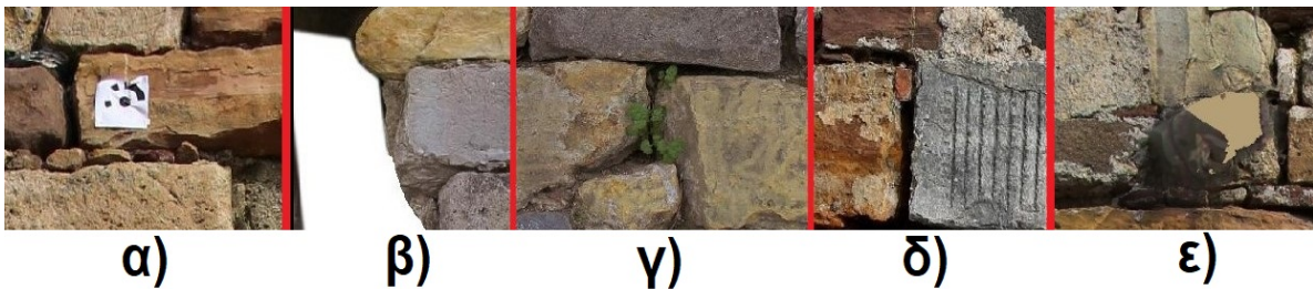
Εικόνα 07: Πληροφορία που δεν πρέπει να κρατηθεί: α) στόχοι φωτοσταθερών, β) εξωτερικά όρια θέματος, γ) βλάστηση, δ) σκαλίσματα, ε) σκαλότρυπες
