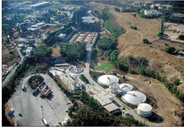
Εικόνα 6-2: Κέντρο Επεξεργασίας Λυμάτων Λυκόθρυσης [46]
