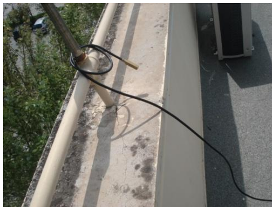
Εικόνα 2.16: Τοποθέτηση εξωτερικού αισθητήρα του AT Meteostation.
