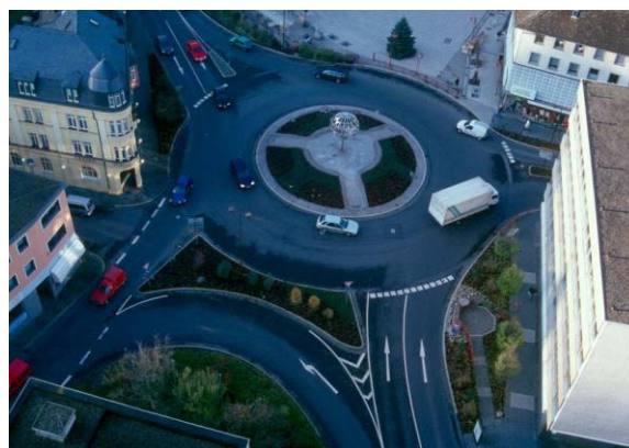
Εικόνα 2.11: Αστικός κυκλικός κόμβος δύο λωρίδων στο Ίνταρ-'Ομπερσταϊν της Γερμανίας
