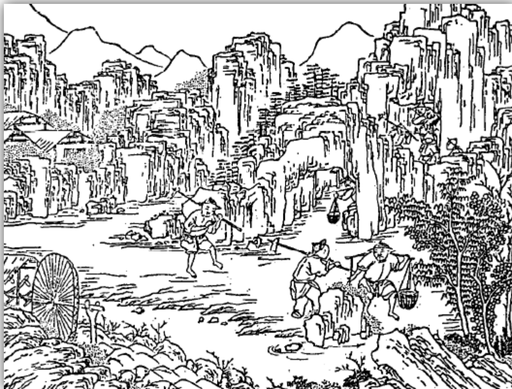
Εικόνα 2.1: Αναπαράσταση εργοταξίου εξαγωγής καολίνη στην Κίνα (1815 Μ.Χ.)
