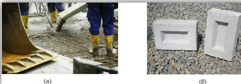
Εικόνα 1.18: Εφαρμογή τσιμέντου Pyrament (R) (α) και (β) πλάκα τσιμέντου από γεωπολυμερές
