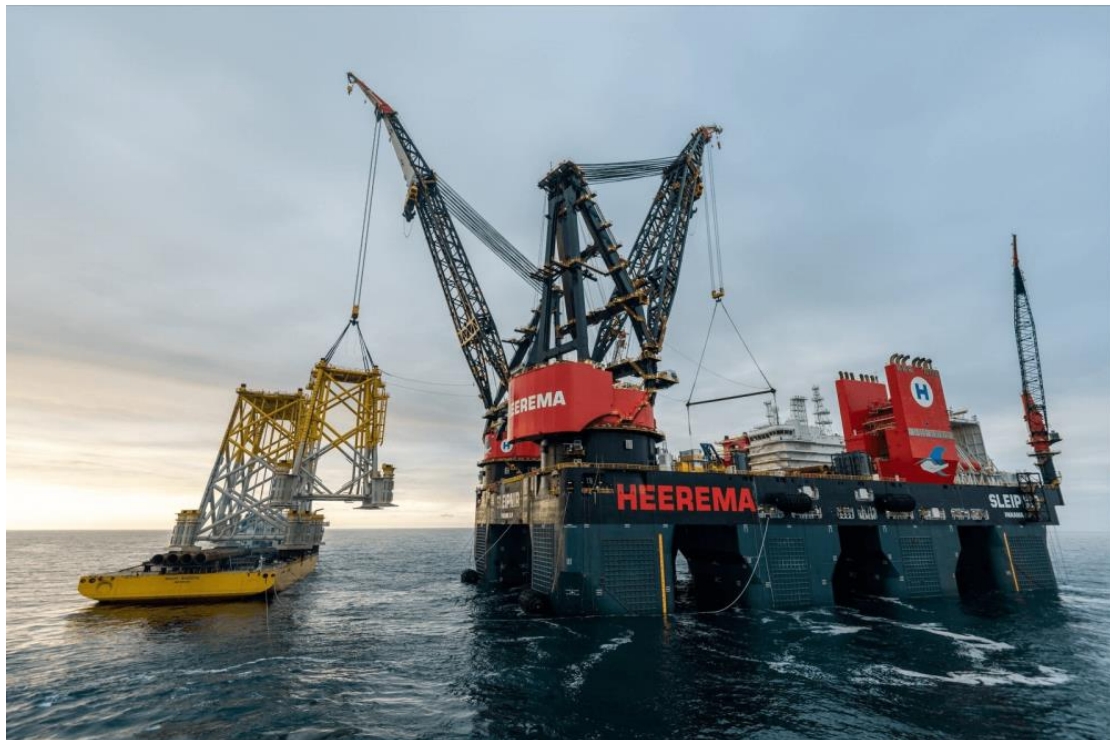
Εικόνα 7: Εγκατάσταση Jacket (Πηγή: Seatower AS)
