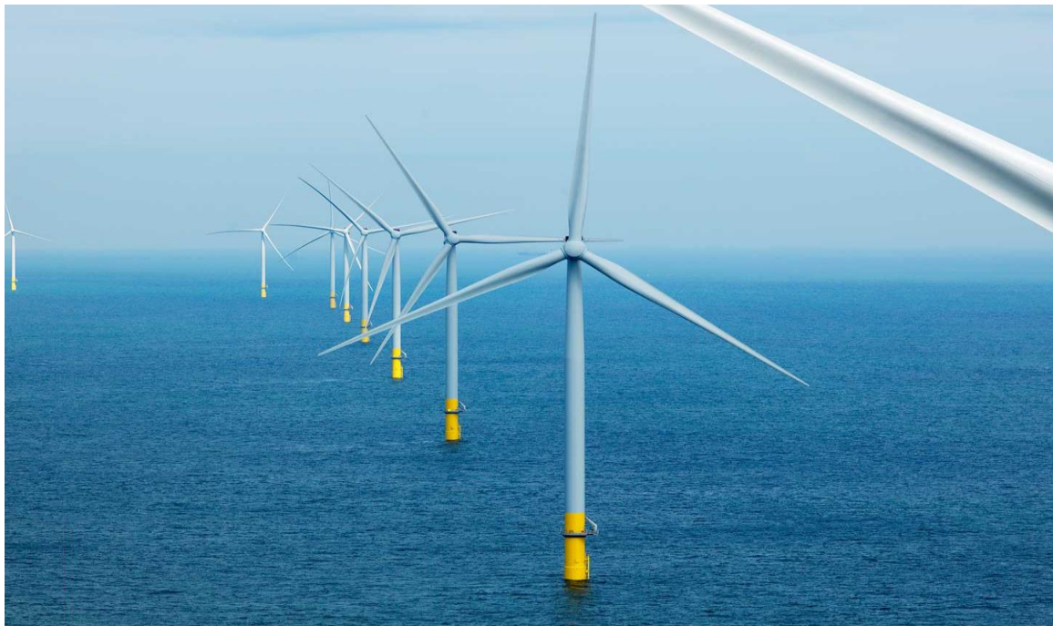
Εικόνα 3: Το πρώτο ολλανδικό υπεράκτιο αιολικό πάρκο της εταιρείας Ørsted (Πηγή: Borssele 1 & 2)
