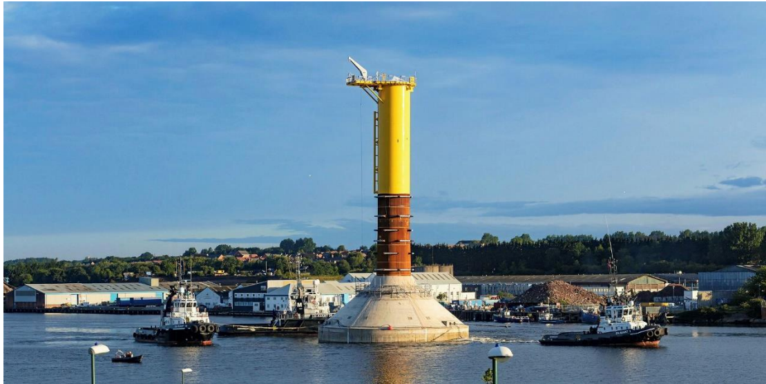
Εικόνα 9: Απεικόνιση της μεταφοράς των Gravity Based Foundation με τη μέθοδο float and submerged (Πηγή: rechargenews)
