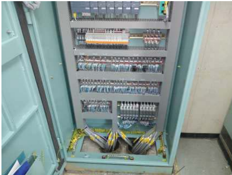
Εικόνα 7.3: Σύνδεση των καλωδίων του Πίνακα Ελέγχου του συστήματος BWTS P1000 EX
