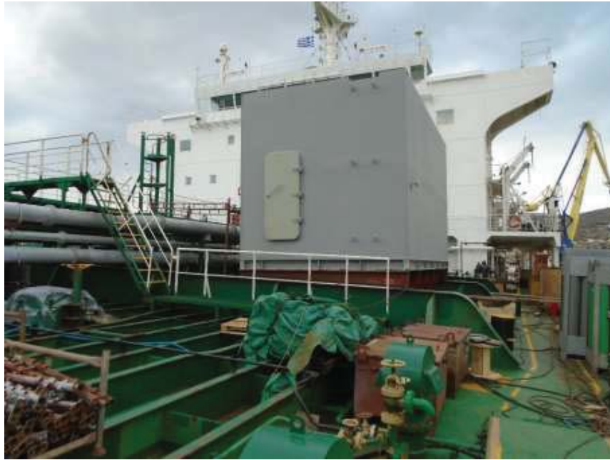
Εικόνα 7.2: Η Υπερκατασκευή του BWTS P1000 EX κατά την διάρκεια της εγκατάστασης
