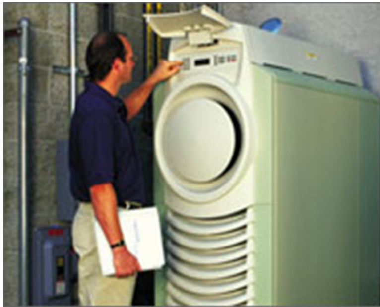
Εικόνα 1.3 : Ένας τεχνικός ρυθμίζει μια μικροτουρμπίνα Capstone
