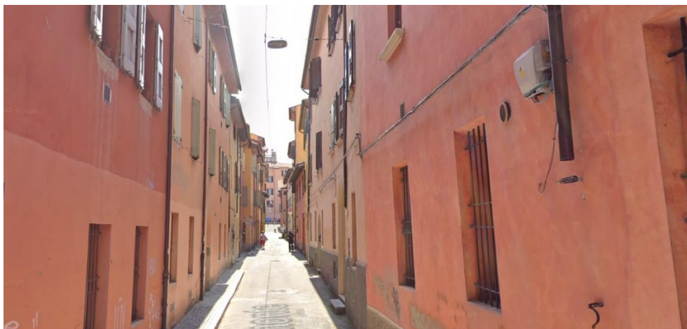
Εικόνα 3.12 Στο υπό εξέταση τμήμα υπάρχει δημόσιος φωτισμός S5=1 (Πηγή: Street View)
