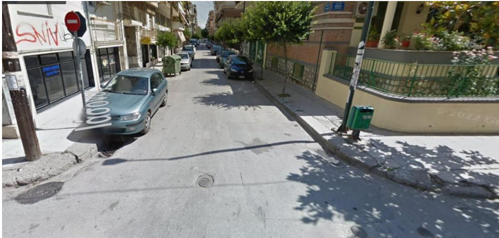
Εικόνα 3.37 Στο υπό εξέταση τμήμα δεν υπάρχουν ράμπες στα άκρα των πεζοδρομίων CI\_2=0 (Πηγή: Street View)
