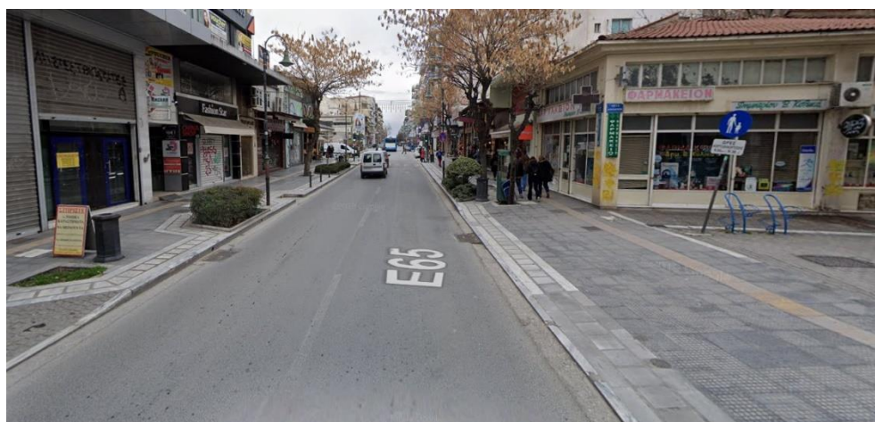
Εικόνα 3.24 Στο υπό εξέταση τμήμα το πεζοδρόμιο δεν έχει εμφανής φθορές S10=1 (Πηγή: Street View)
