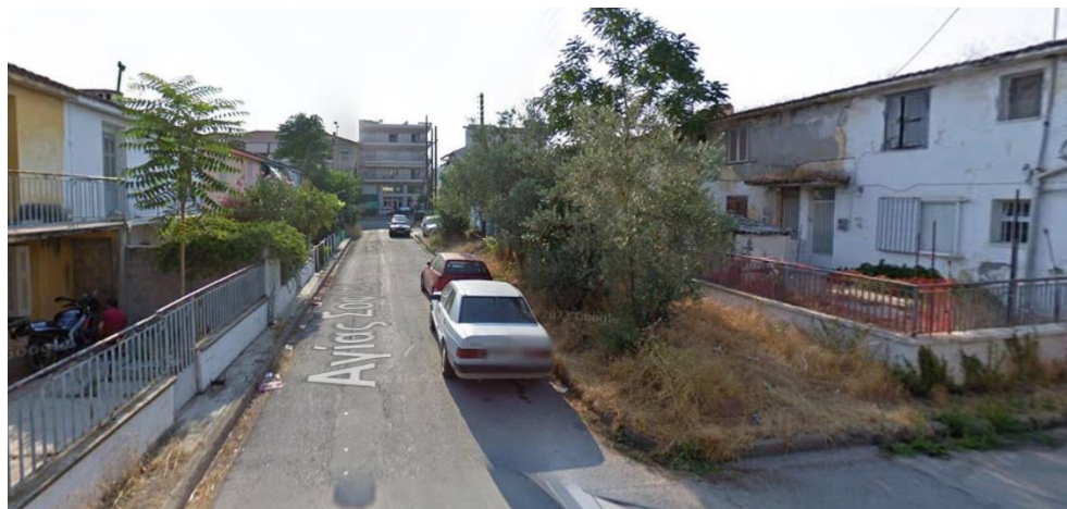
Εικόνα 3.23 Στο υπό εξέταση τμήμα το πεζοδρόμιο έχει εμφανής φθορές S10=0 (Πηγή: Street View)
