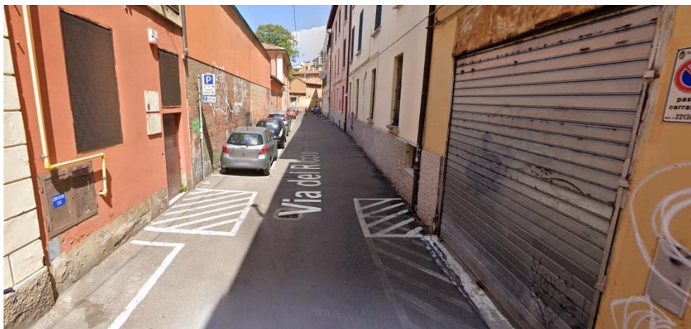
Εικόνα 3.21 Στο υπό εξέταση τμήμα δεν υπάρχει πεζοδρόμιο S9=0 (Πηγή: Street View)
