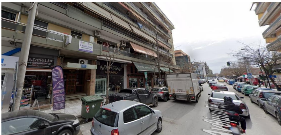
Εικόνα 3.15 Στο υπό εξέταση τμήμα δεν υπάρχουν εμφανής φθορές στα κτίρια S6=1 (Πηγή: Street View)
