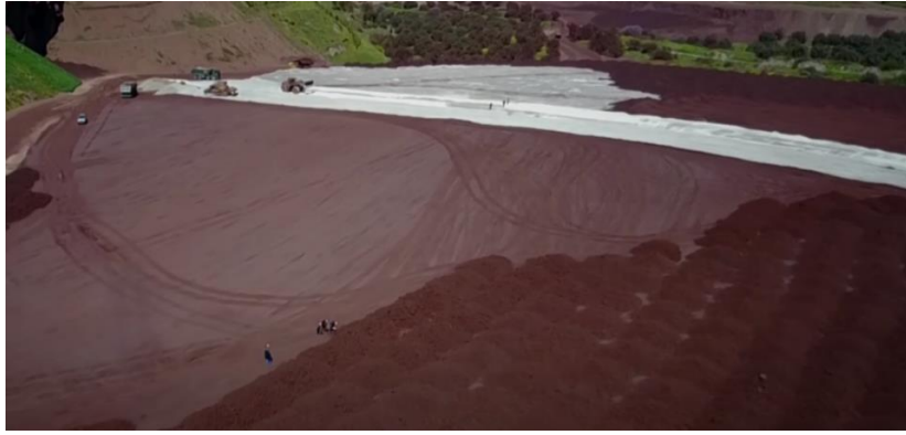
Εικόνα 9: Χώρος απόθεσης βωξιτικών καταλοίπων με τη μέθοδο dry stacking. [32]
