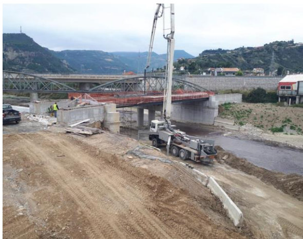
Εικόνα 3-9 Κατασκευή στον ποταμό Σύθα (Πηγή: 12 η ετήσια έκθεση ΟΛΥΜΠΙΑ ΟΔΟΣ ΑΕ)
