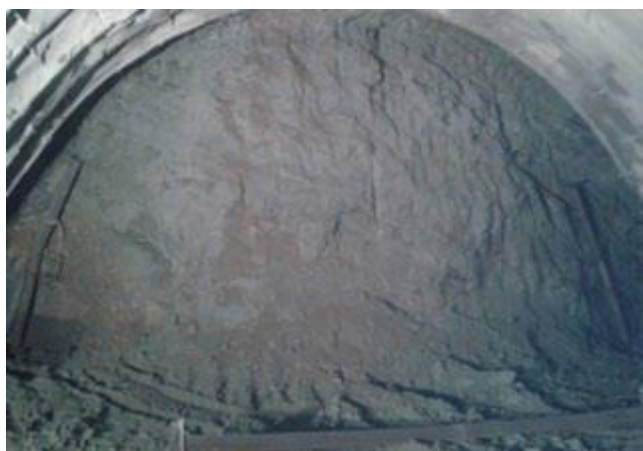
Εικόνα 3-5 Α' φάση εκσκαφής σήραγγας (Πηγή: 7 η ετήσια έκθεση ΟΛΥΝΠΙΑ ΟΔΟΣ ΑΕ)
