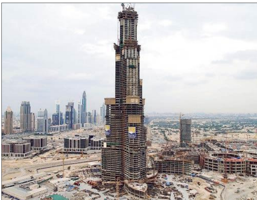
Εικόνα 1.5: Burj Dubai construction phase.
