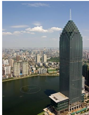
Εικόνα 1.2: Minsheng Bank Building
