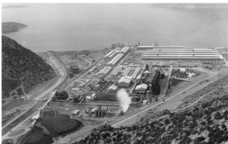
Εικόνα 16. Ολοκλήρωση Εργοστασίου (έτος 1966).
