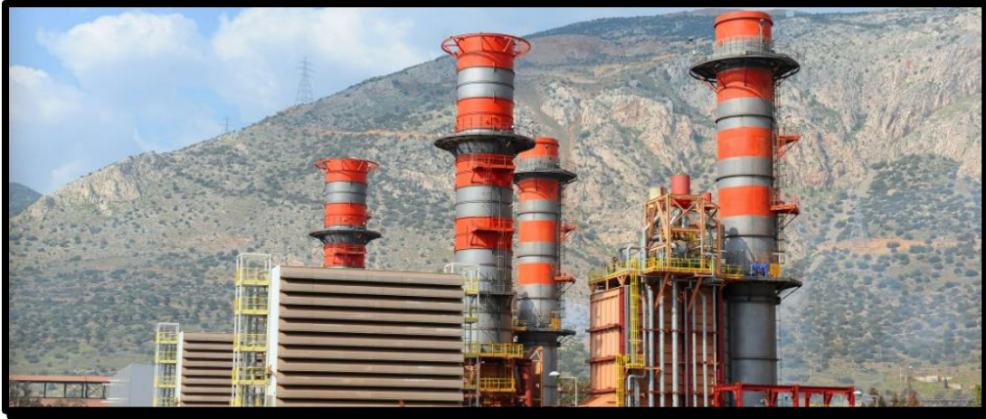
Εικόνα 13. Σταθμός Συμπαγωγής Ηλεκτρισμού και Θερμότητας Υψηλής Απόδοσης
