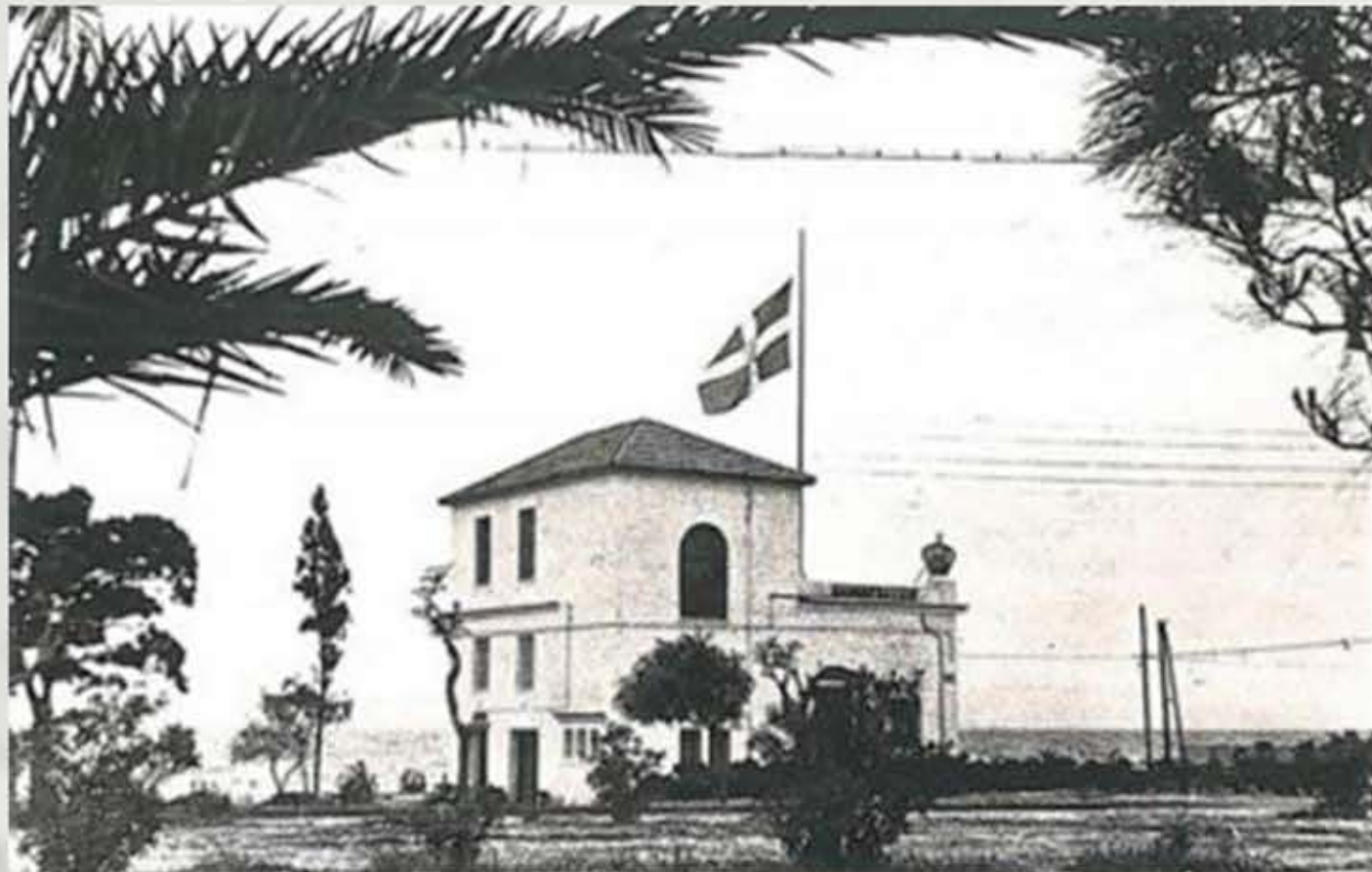
Δημαρχείο Γλυφάδας_1950 Πηγή: Δρίκος Θ., ΓΛΥΦΑΔΑ
