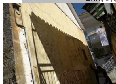
Εικόνα 35 Ανατολική Όψη. Διακρίνεται το χαμηλωμένο τόξο του ιερού, για τη διευκόλυνση της διέλευσης
