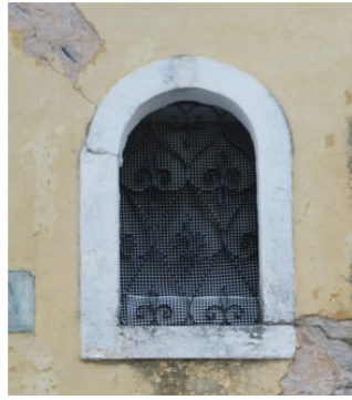
Εικόνα 96 θραύση των λαξευτών λίθων του τόξου στην περιοχή σύνδεσής του με το λαμπά σε άνοιγμα της βόρειας όψης
