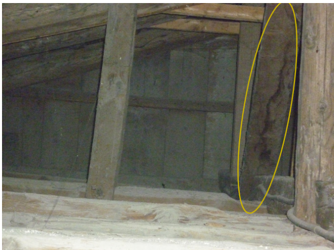
Εικόνα 54 Διαγώνιος επιμήκης σύνδεσμος
