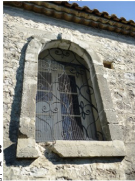
Εικόνα 96 θραύση των λαξευτών λίθων του τόξου στην περιοχή σύνδεσής του με το λαμπά σε άνοιγμα της βόρειας όψης
