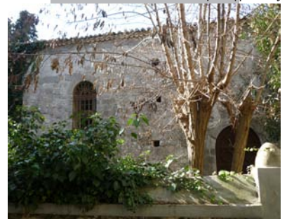
Εικόνα 11 Πίσω όψη ΙΝ Παντοκράτορος: Διακρίνεται η ακανόνιστη δόμηση, αλλά και μεταγενέστερη επέμβαση με σενάζ ΩΣ
