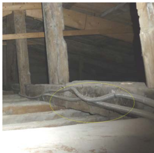
Εικόνα 55 Λεπτομέρεια έδρασης σάφρας στους ενδιάμεσους ελκυστήρες
