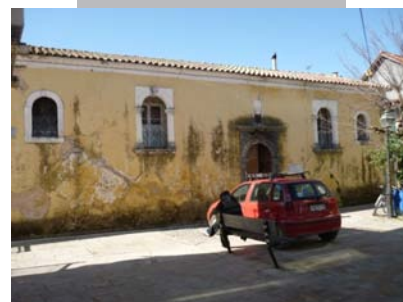
Εικόνα 32 Βόρεια όψη του Ι.Ν. Αγ. Γεωργίου
