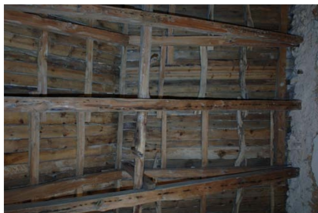
Εικόνα 59 Στέγη ΙΝ Αγίου Γεωργίου στους Σκάρους. Εφαρμόζεται και εδώ το σύστημα «δοκός επί στύλου»
