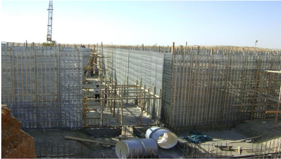
Σχήμα 1.1 Κατασκευή δεξαμενής από οπλισμένο σκυρόδεμα.
