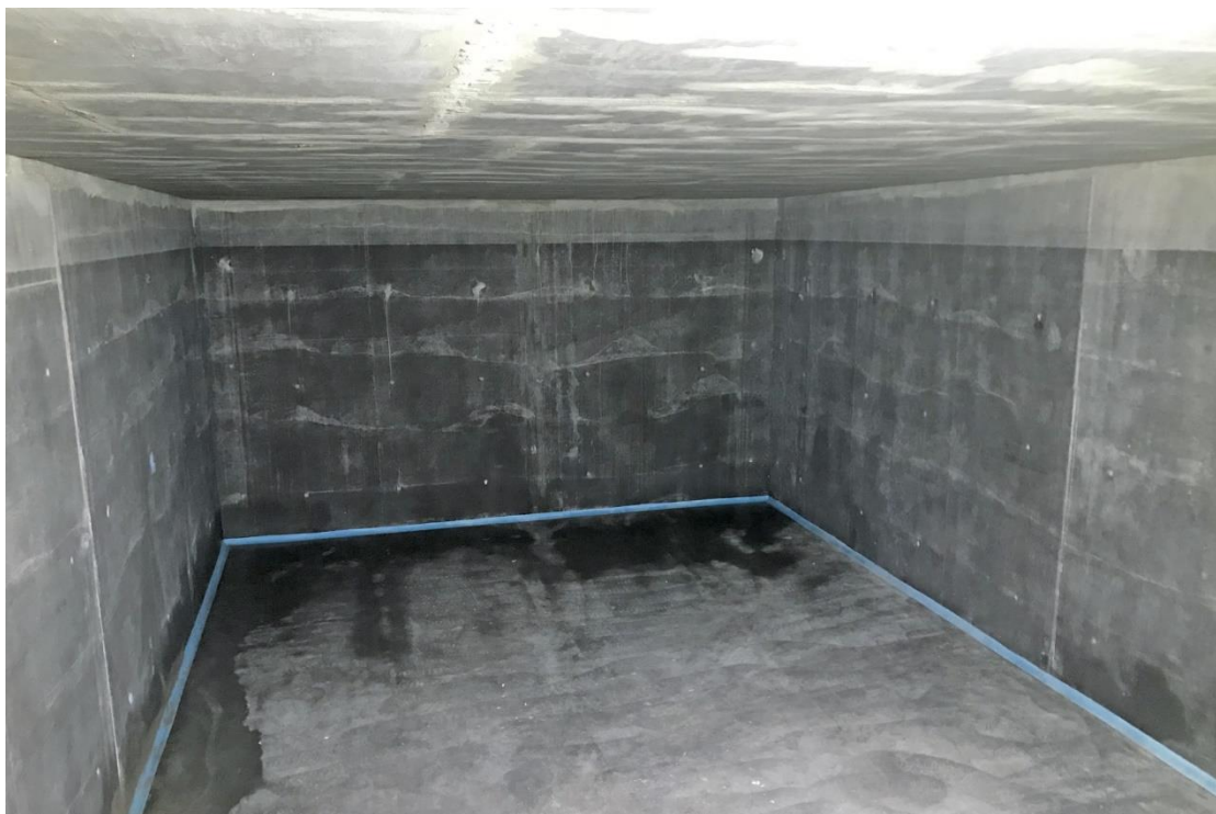
Σχήμα 1.2 Εσωτερικό υδατοδεξαμενής από σκυρόδεμα.
