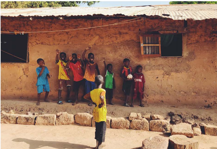
ΚΑΤΟΙΚΙΑ ΜΕ ΤΟΥΒΛΑ ΚΑΙ ΣΟΒΑ ΑΠΟ ΤΟΠΙΚΟ ΚΟΚΚΙΝΟ ΧΩΜΑ ΚΑΙ ΣΤΕΓΗ ΑΠΟ ΜΕΤΑΛΛΟ
