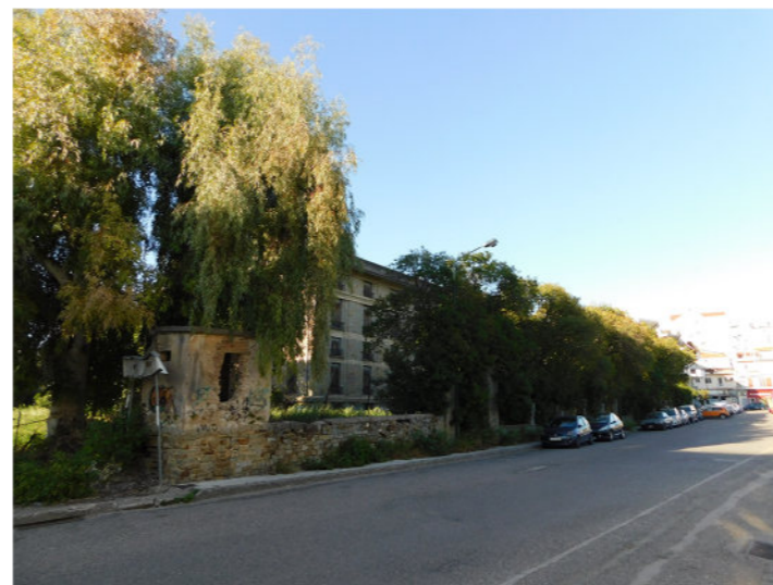
Εικόνα 57. Νότια όψη, έξω από την περίφραξη.
