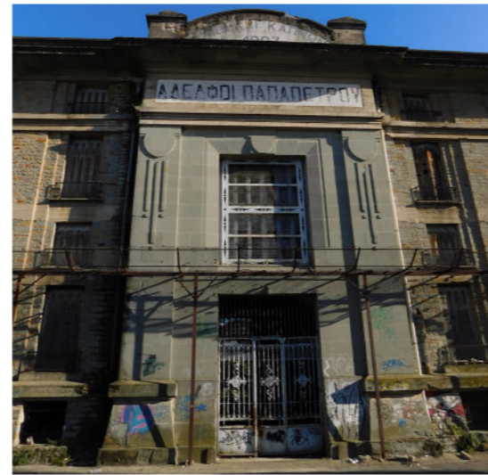
Εικόνα 54. Κεντρικό μέρος της βόρειας όψης.
