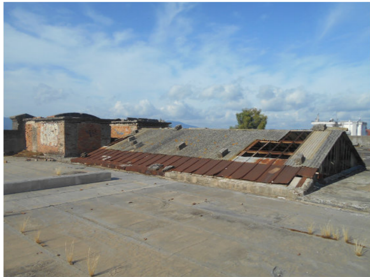
Εικόνα 43. Δώμα κτηρίου. Διακρίνονται η στέγη, τα κτίσματα από πλινθοδομή που καταλήγει το κλιμακοστάσιο και η προεξοχή κατάληξης του εξαερισμού στην πλάκα.
