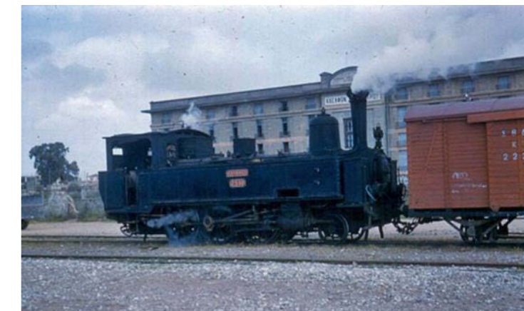
Εικόνα 37. Αναχώρηση εμπορικού συρμού από τον σταθμό Αγρινίου. Μπροστά από τις καπναποθήκες «Αφοί Παπαπέτρου», δίπλα από τον σταθμό. (Μάιος 1962)
