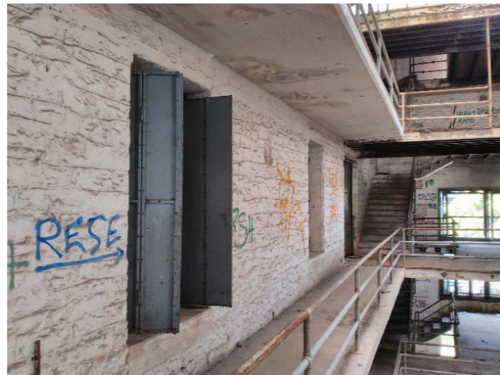
Εικόνα 46. Δίφυλλα μεταλλικά κουφώματα.
