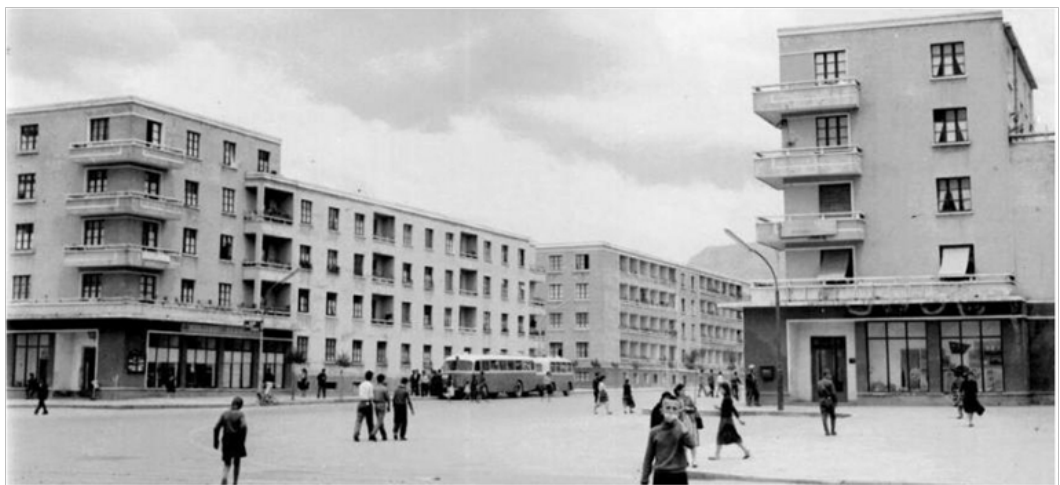
εικόνα 4.10_Συλλογικά συγκροτήματα κατοικιών που ορίζουν νέα όρια για το κέντρο της πόλης (τέλη '60-αρχές '70). (Πηγή: National Technical Archive)
