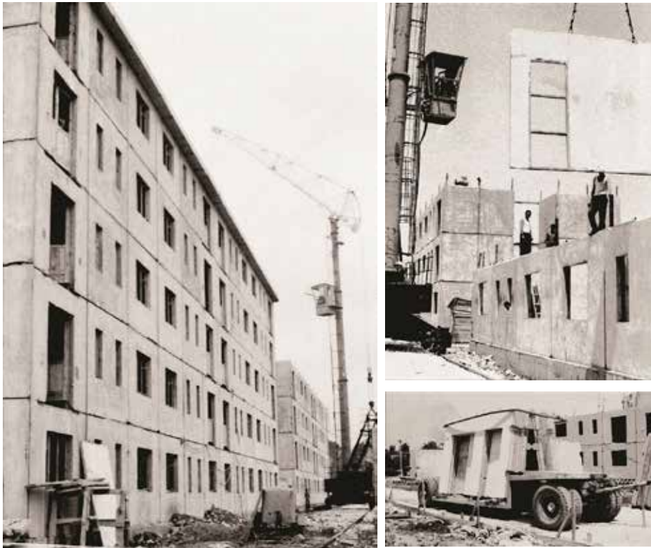
εικόνα 5.2_ Κατασκευή συγκροτήματος από προκατασκευασμένα πάνελ σκυροδέματος (Πηγή: National Technical Archive)
