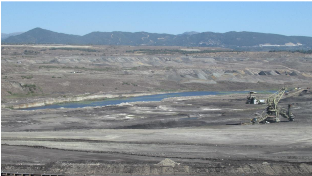
Εικόνα 45. Αντλιοστάσιο P24 στο Ορυχείο Χωρεμίου
