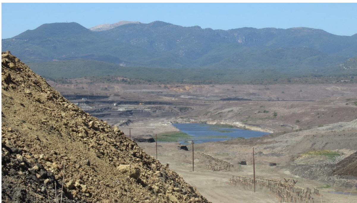
Εικόνα 83. Αντλιοστάσιο P24 στο Ορυχείο Χωρεμίου
