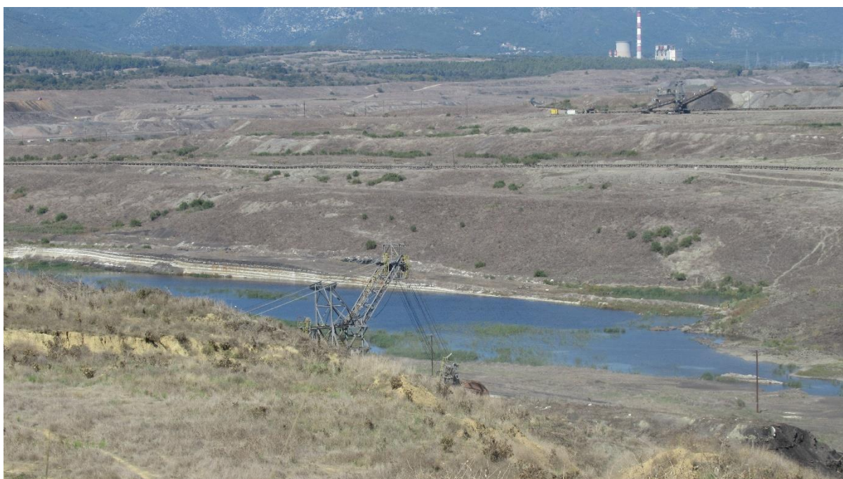
Εικόνα 84. Αντλιοστάσιο P24 στο Ορυχείο Χωρεμίου
