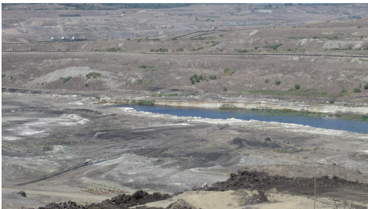
Εικόνα 82. Αντλιοστάσιο P24 στο Ορυχείο Χωρεμίου
