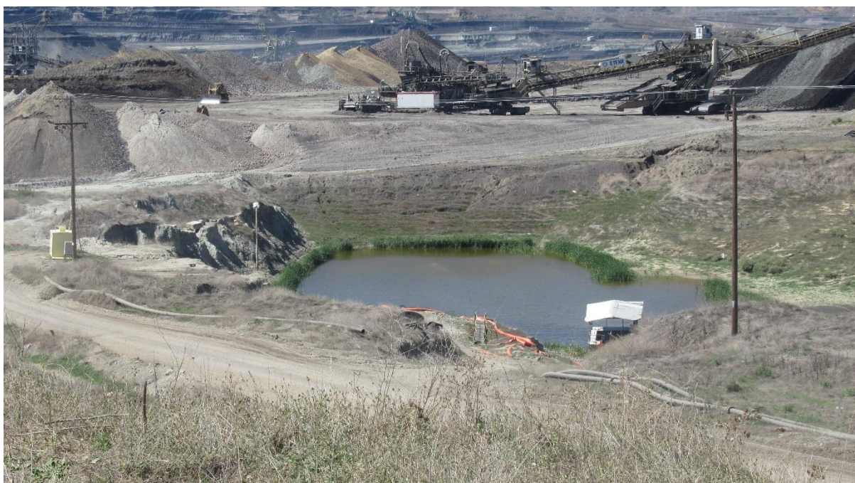
Εικόνα 86. Λεκάνη καθίζησης και αντλιοστάσιο στο Ορυχείο Χωρεμίου
