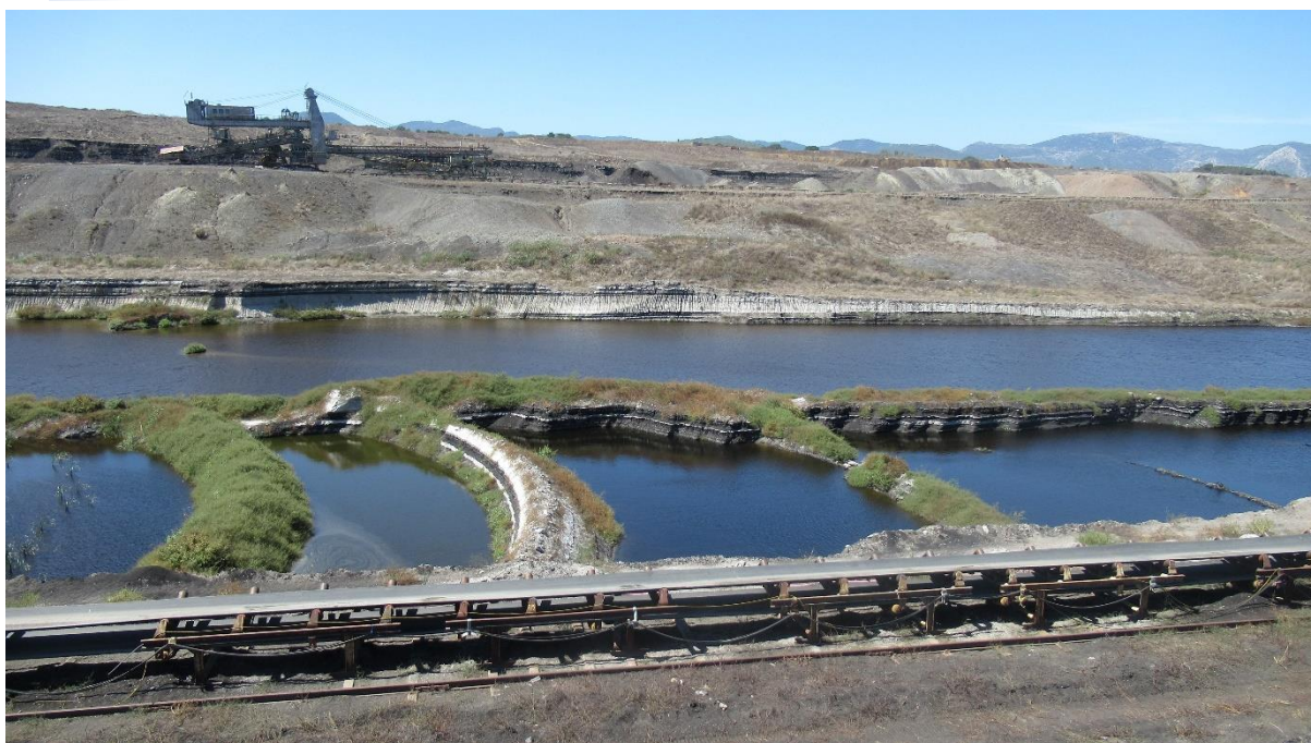
Εικόνα 87. Αντλιοστάσιο P13 στο Ορυχείο Χωρεμίου
