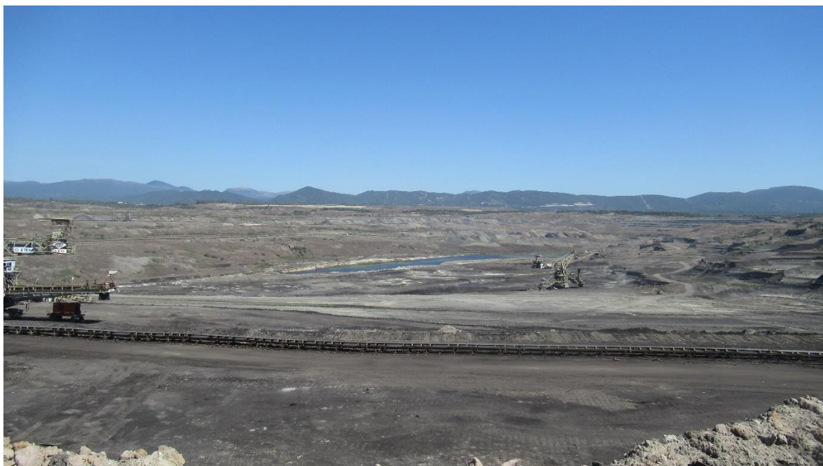
Εικόνα 81. Αντλιοστάσιο P24 στο Ορυχείο Χωρεμίου (μακρινή λήψη)
