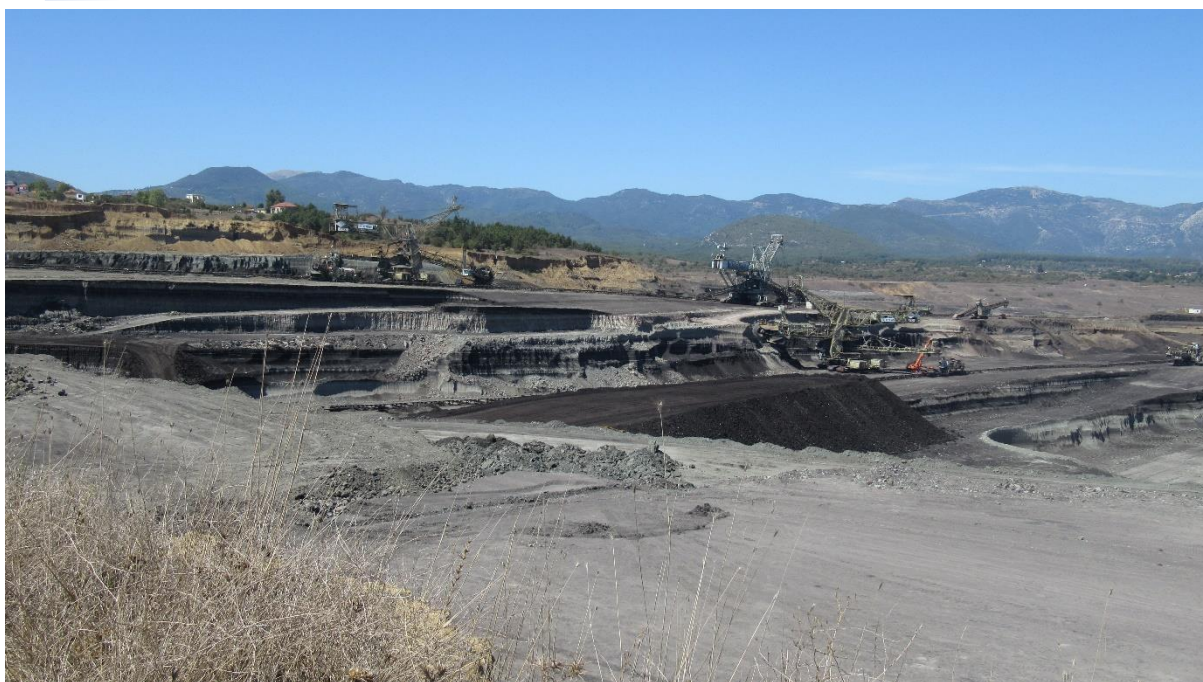
Εικόνα 85. Εξορυκτικές εργασίες δίπλα στο Αντλιοστάσιο P24
