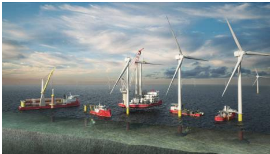
Εικόνα 2.3. Ενδεικτικός στόλος εγκατάστασης και συντήρησης ενός υπεράκτιου αιολικού πάρκου. [12]
