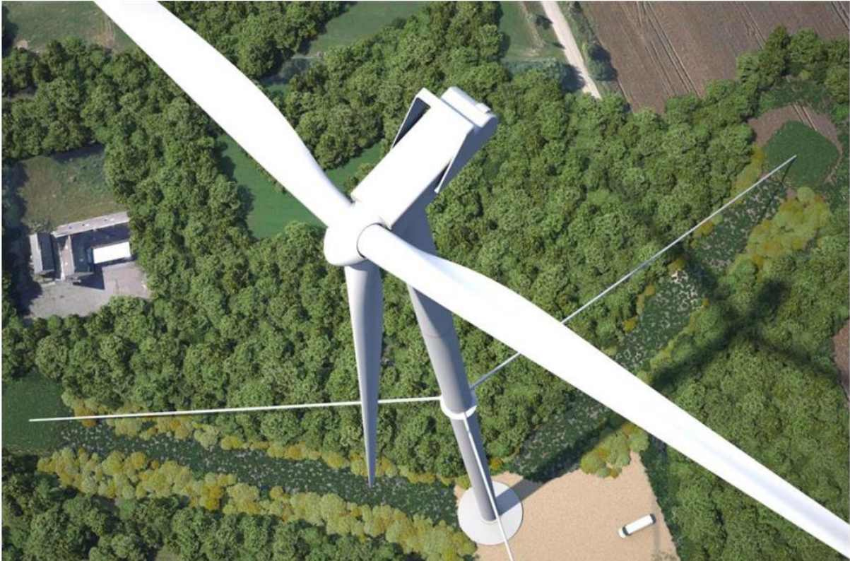
Εικόνα 4-3: Φωτορεαλιστική απεικόνιση καλωδιωτής ανεμογεννήτριας Vestas
