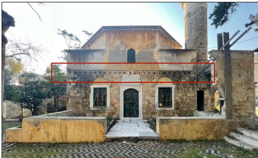
Σωζόμενο τμήμα του λίθινου προστώου ΒΔ όψη. Διακρίνονται οι 29 δοκοθήκες κατά μήκος της όψης.
