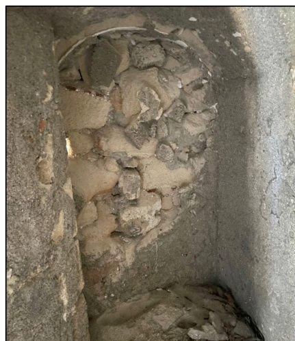
Χτίσιμο του ανοίγματος του προηγούμενου μιναρέ - Ο αρμός είναι εμφανής στον ΝΔ τοίχο της σάλας προσευχής.
