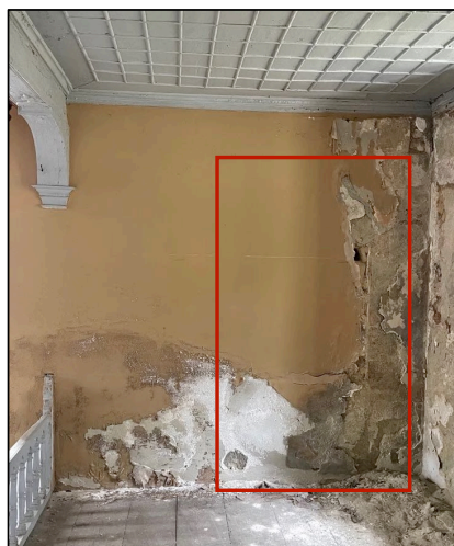
Χτίσιμο του ανοίγματος του προηγούμενου μιναρέ - Ο αρμός είναι εμφανής στον ΝΔ τοίχο της σάλας προσευχής.
