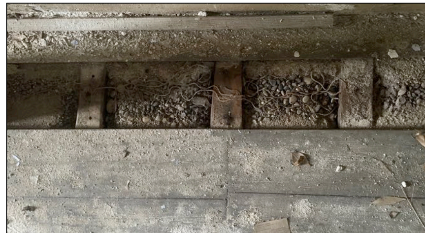
Δάπεδο ισογείου - Πλήρωση κενού ανάμεσα στις τειγίδες με βότσαλα
