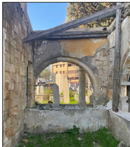
Στήριξη δοκών του δώματος στις δοκοθήκες της ΒΔ όψης
