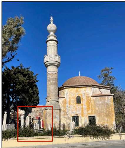
Σωζόμενο τμήμα του λίθινου προστώου ΝΔ όψη. Διακρίνεται η υδρορροή.
