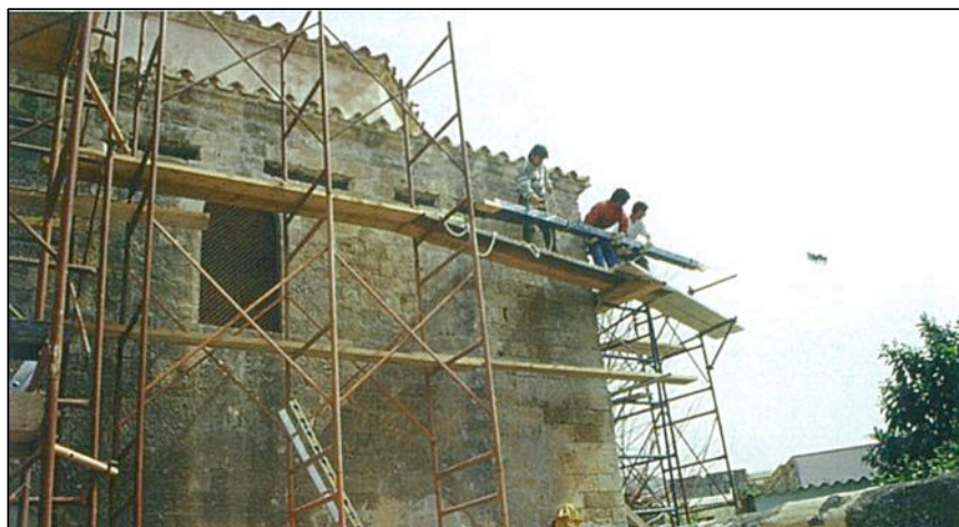
Διαδικασία τοποθέτησης νέων ξυλοδεσιών κατά την αποκατάσταση του τεμένους Χαμζά Μπέη στην Μεσαιωνική πόλη της Ρόδου.
