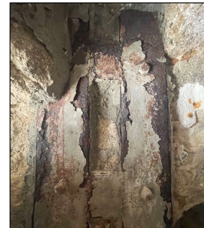
Επέμβαση ενίσχυσης με λάμες και μηχανικά βλήτρα. Σήμερα έχουν διαβρωθεί.
