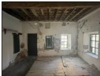
χώρος 1: Δυτικός τοίχος
