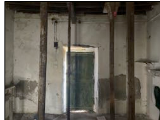
χώρος 3: Βόρειος τοίχος
