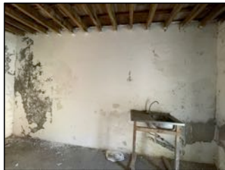
χώρος 3: Δυτικός τοίχος
