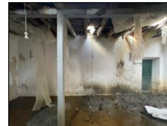
χώρος 2: Δυτικός τοίχος
