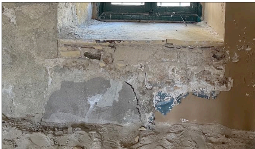
Λίθοι στην εσωτερική παρειά της λιθοδομής
