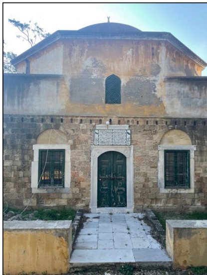
Ανεπίχριστο τμήμα της ΒΔ όψης από λαξευμένο πωρόλιθο σε δόμους
