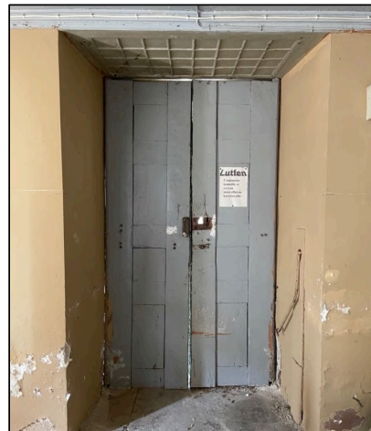
Εσωτερική όψη θύρας εισόδου
