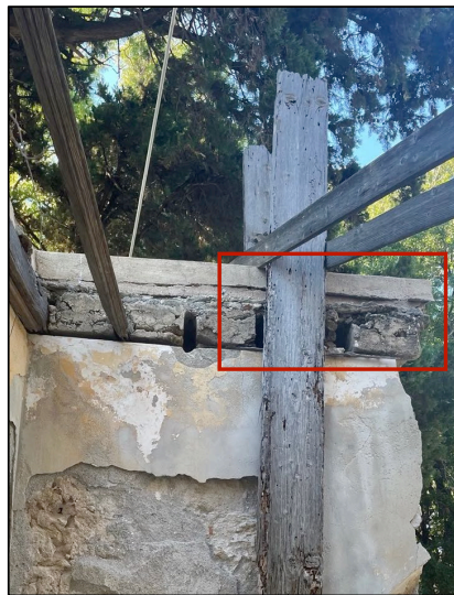
Δοκοθήκες στην εσωτερική μεριά του λίθινου προστώου. Δεξιά διακρίνονται υπολείμματα πατελιάς.
