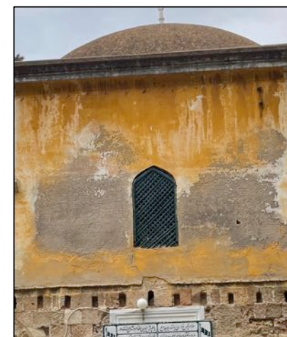
Εξωτερική όψη φεγγίτη
