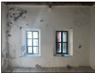
χώρος 1: Βόρειος τοίχος
