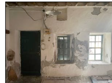
Έντονα προβλήματα υγρασίας και αποκόλλησης επιχρισμάτων
