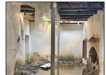
χώρος 2: Βόρειος τοίχος
