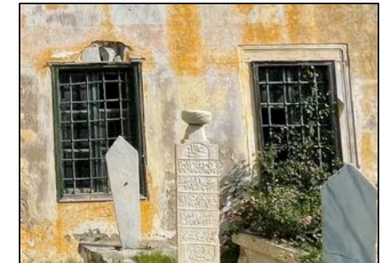
Δεξιά βλέπουμε το παράθυρο με το μαρμάρινο πλαίσιο με κυμάτια. Στο αριστερό παράθυρο διακρίνουμε το ίχνος του μαρμαρίνου πλαισίου που βρίσκεται κάτω από τον σοβά.
