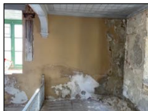
Προβλήματα ανερχόμενης υγρασίας
