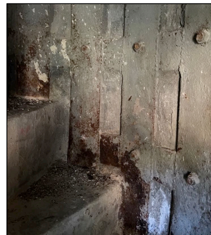
Επέμβαση ενίσχυσης με λάμες και μηχανικά βλήτρα. Σήμερα έχουν διαβρωθεί.
