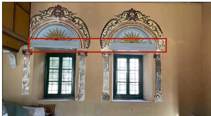
Ξύλινο πρέκι ανοιγμάτων.- πιθανή ταύτιση με σύστημα ξυλοδεσιών
