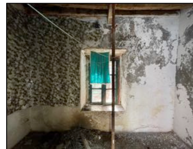
Έντονα προβλήματα υγρασίας και αποκόλλησης επιχρισμάτων
