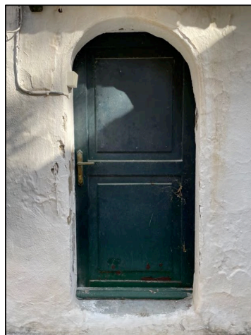
Ταμπλαδοτή θύρα χώρου 1
