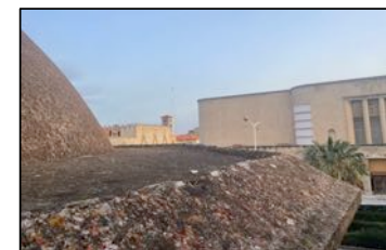
Ο ημισφαιρικός θόλος - επιχρισμένος με κουρασανί φωτογραφίες από την επιτόπια έρευνα (Μάρτιος 2022)
