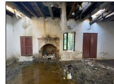
Σήψη ξύλινων στοιχείων και τμηματική κατάρρευση οροφής
