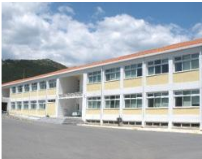
Εικόνα 11.31 : Το κτίρια από τα τμήματα του Πανεπιστημίου Πελοποννήσου που εδράζονται στην Τρίπολη ( http://cst.uop.gr )
