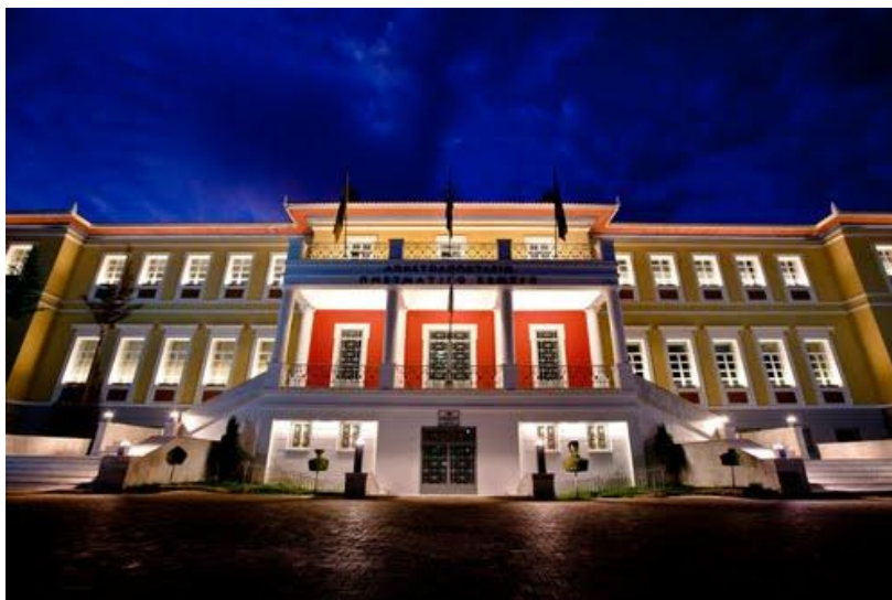
Εικόνα 11.27 : Το Αποστολοπούλειο Πνευματικό Κέντρο Τρίπολης ( http://www.panoramio.com/photo/44735159?source=wapi&referrer=kh.google.com )
