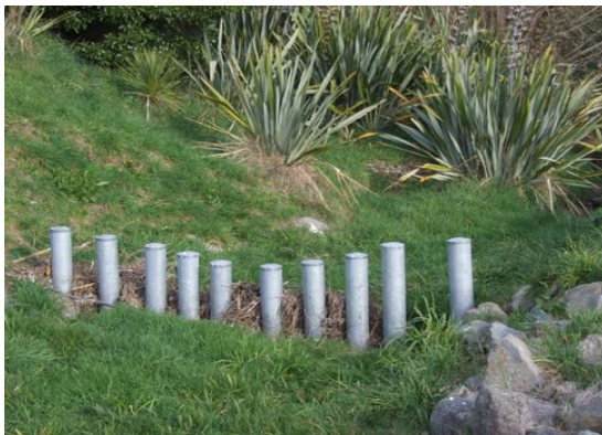
Σχήμα 32. Συστοιχία πασσάλων σε φυτεμένο κανάλι στο Christchurch της Νέας Ζηλανδίας και δίκτυο-φραγμός μακρορύπων (Waterways, Wetlands and Drainage Guide, 2012).
