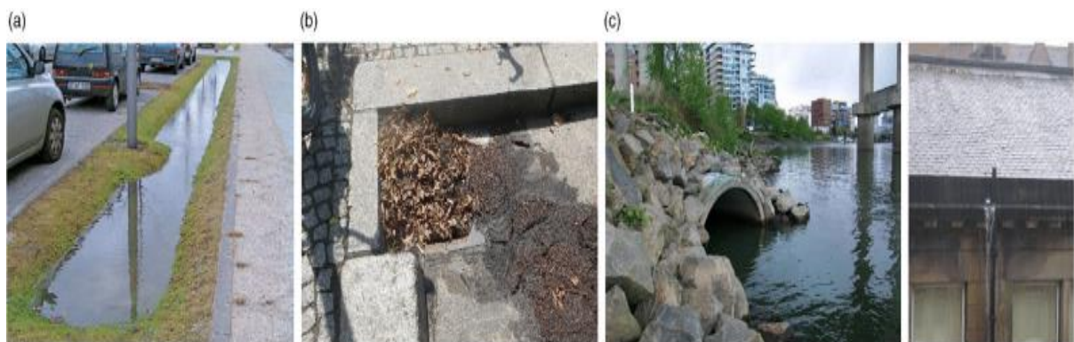
Σχήμα 8. Ρυθμιστές, φραγμοί και επιταχυντές της αστικής διάχυτης ρύπανσης: (a) φυτεμένο κανάλι μετά από βροχόπτωση, (b) φραγμένη εσχάρα δικτύου ομβρίων, (c) Εκβολή του δικτύου ομβρίων σε αστικό ποταμό και υδρορροή (Paton κ.ά., 2021).
