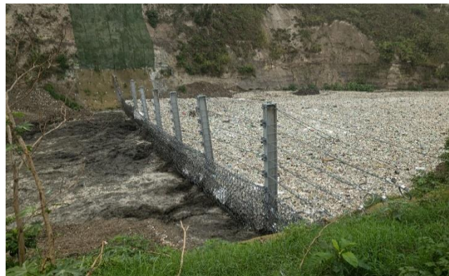
Σχήμα 32. Συστοιχία πασσάλων σε φυτεμένο κανάλι στο Christchurch της Νέας Ζηλανδίας και δίκτυο-φραγμός μακρορύπων (Waterways, Wetlands and Drainage Guide, 2012).
