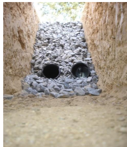
Σχήμα 24. α. Διατομή μιας τυπικής τάφρου διήθησης, πληρωμένη με αδρόκοκκο υλικό και γεωύφασμα για την παρεμπόδιση της έμφραξης των πόρων μεταξύ των λίθων (Qin, 2020). β. Τάφος διήθησης με διάτρητους στραγγιστικούς αγωγούς.
