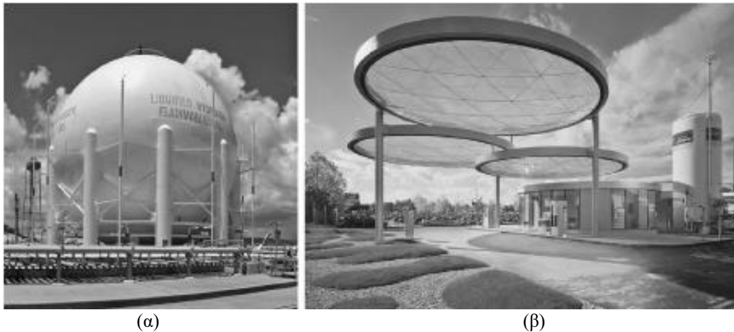
Σχήμα 2.6. α) σφαιρική δεξαμενή LH 2 , NASA β) οριζόντια δεξαμενή LH 2 , Κέντρο Υδρογόνου Linde [37].
