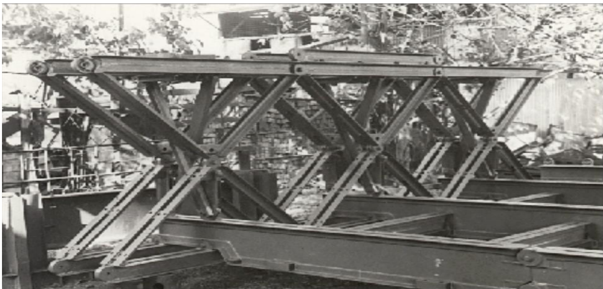
Σχήμα 2-14: Σχήμα 2 14: Διαμόρφωση δικτυώματος γέφυρας Quadricon ,Πηγή:[17]
