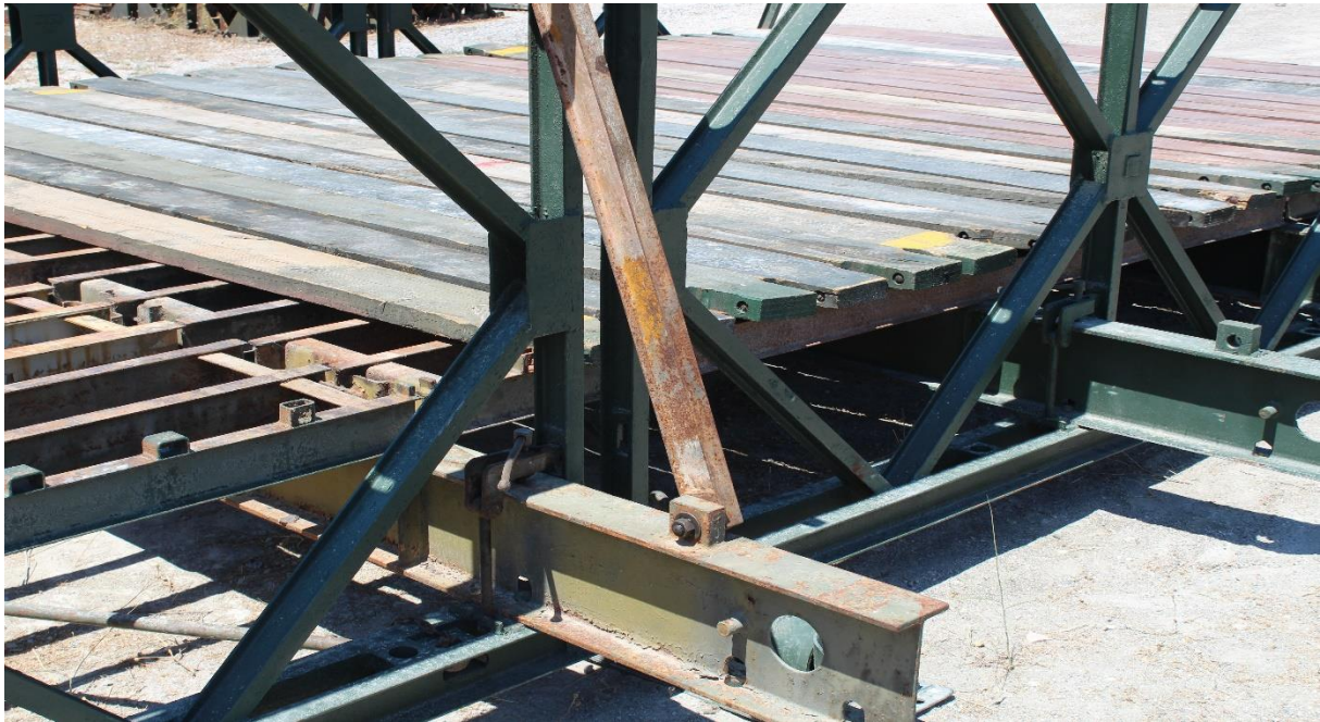
Σχήμα 4-4: Σύνδεση αντηρίδας με διαδοκίδα
