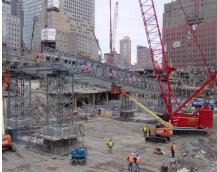
Σχήμα 2-6:Ανέγερση της γέφυρας Acrow 700XS,Νέα Υόρκη,Πηγή: www.acrowusa.com
