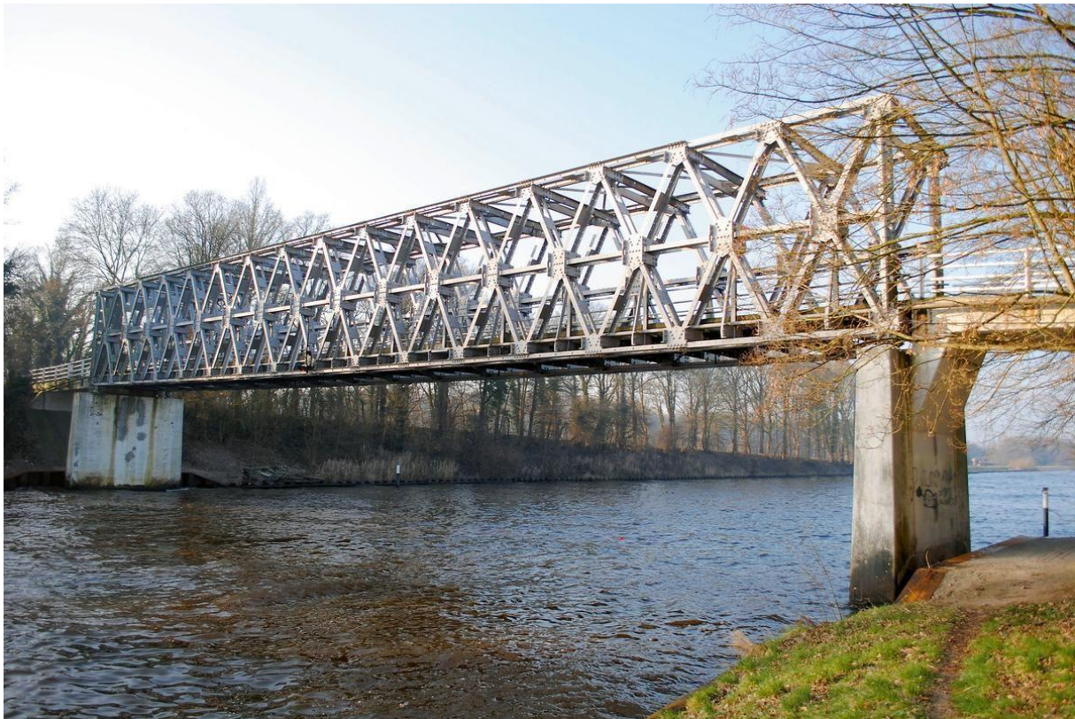
Σχήμα 2-1: Γέφυρα Callender-Hamilton στο χωριό Almen, στην Ολλανδική επαρχία Gelderland, (Πηγή: https://structurae.net/en/structures/ehzerbrug )
