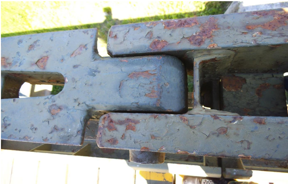
Σχήμα 4-7: Σύνδεση πλαισίων σε κάτοψη
