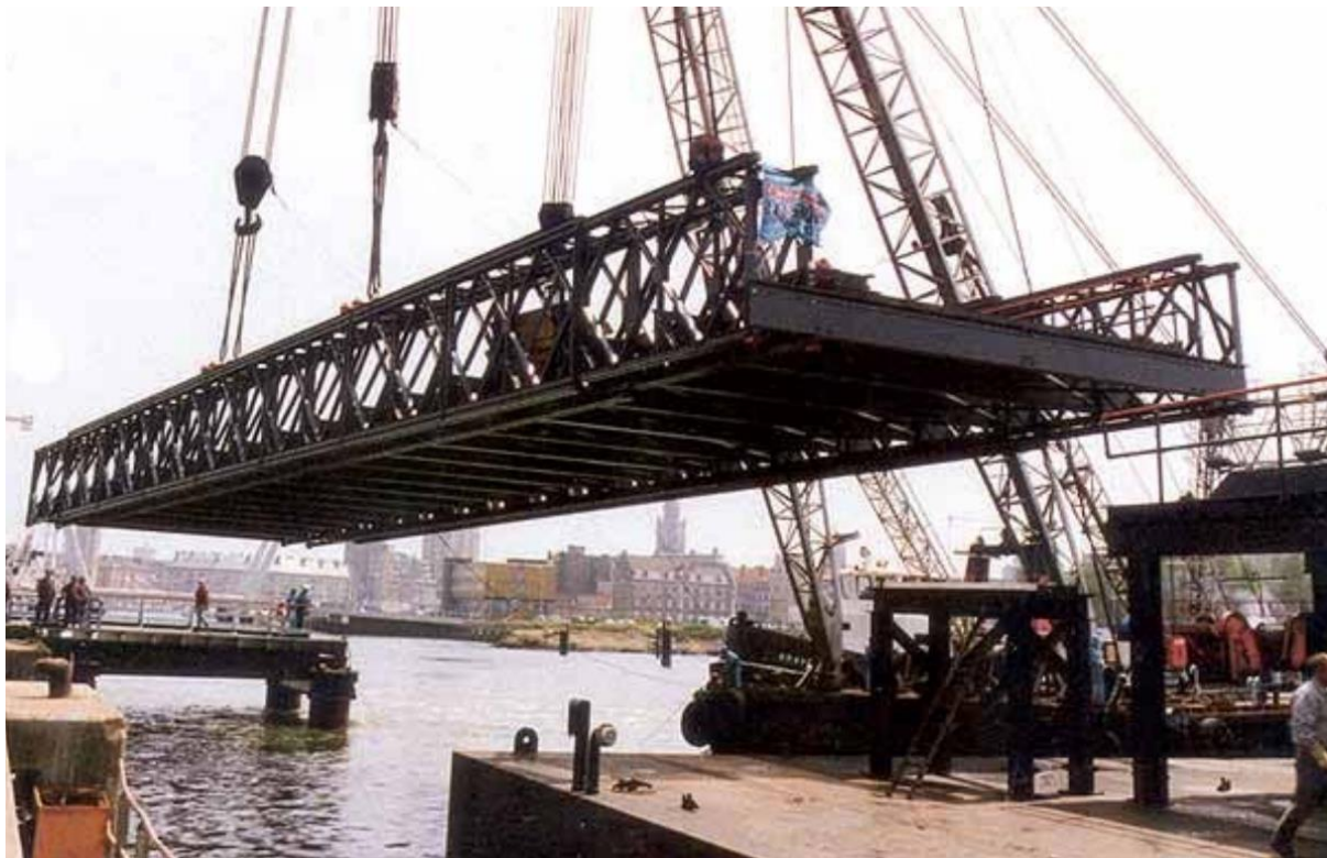
Σχήμα 2-12: HBP κατά τη διάρκεια της ανέγερσης, Πηγή: www.jansonbridging.com
