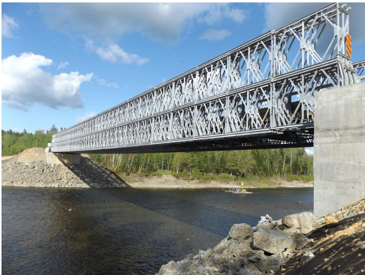
Σχήμα 2-4: Γέφυρα Acrow ανοίγματος 79,3m στην канаδική κοινότητα Kedgwick της κομητείας Restigouche, New Brunswick
