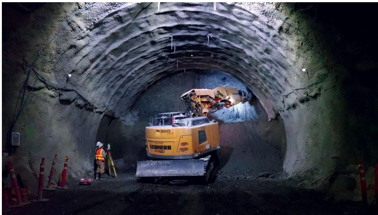
Εικόνα 2-8: Μεταλλικά πλαίσια της πρώτης κατηγορίας και χρήση τους κατά τη μέθοδο NATM (ijsart.com)
