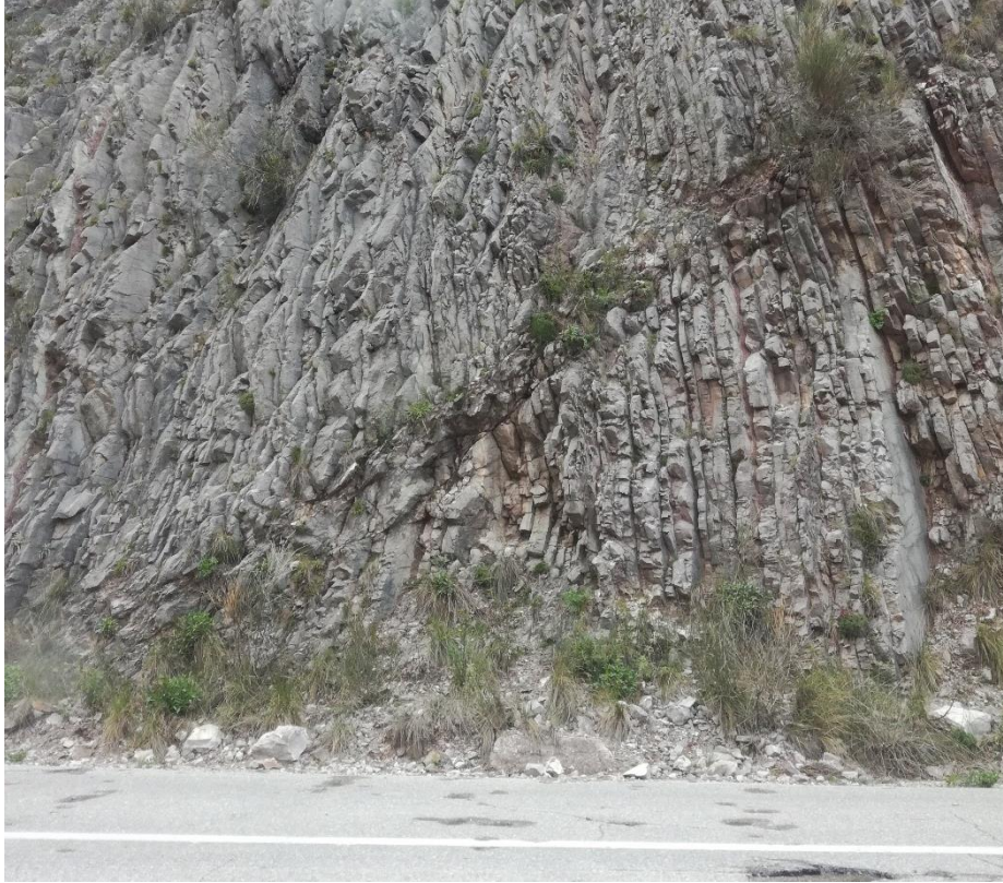
Εικόνα 4-16: Λεπτοστρωματώδεις ασβεστόλιθοι του ανώτερου Κρητιδικού στην περιοχή του έργου Επιπλέον για μεγαλύτερη εποπτεία του γεωλογικού υποβάθρου παρουσιάζονται αεροφωτογραφίες από την περιοχή του έργου.
