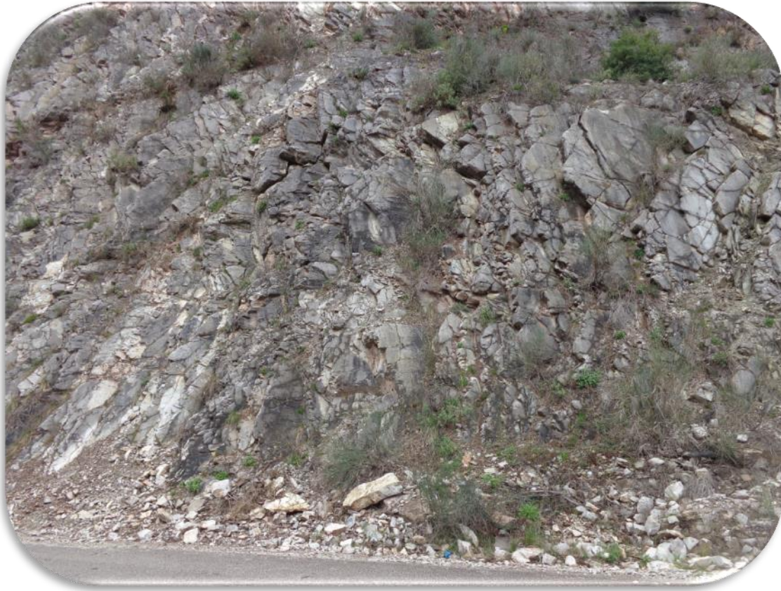
Εικόνα 5-2: ΤΕ 2 : Τύπος D: Τεμαχώδης μερικώς κερματισμένος ασβεστόλιθος.
