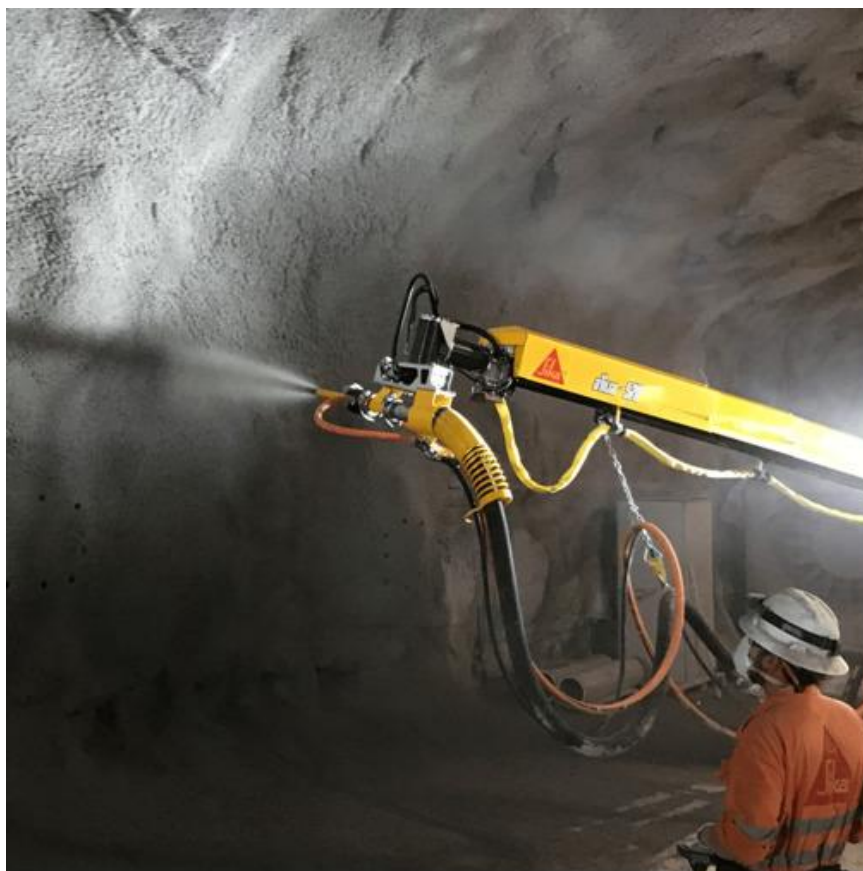
Εικόνα 2-6: Παράδειγμα εφαρμογής εκτοξευόμενου σκυροδέματος (Sika Canada: can.sika.com )
