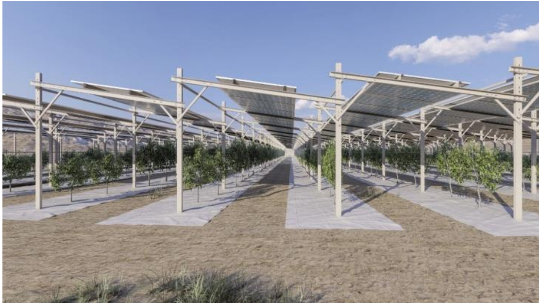
Εικόνα 2.10 Οπωροβολταϊκά διπλής όψης στο Ισραήλ, (pv-magazine.com)
