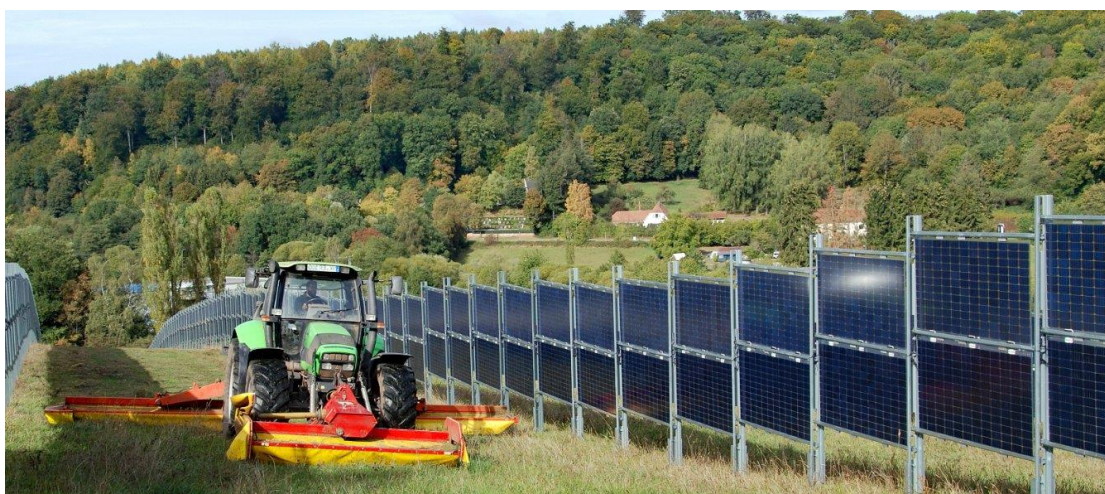
Εικόνα 2.7 Πιλοτικό σύστημα κάθετων αγροβολταϊκών στην Σουηδία (pv-magazine.com)
