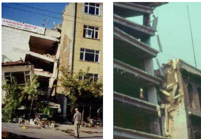
Σχήμα 2.2 Περιπτώσεις κρούσης γειτονικών κτιρίων.
