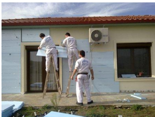
Εικόνα 5.5 Στρωματοποίηση εξωτερικής θερμομόνωσης.[40]
