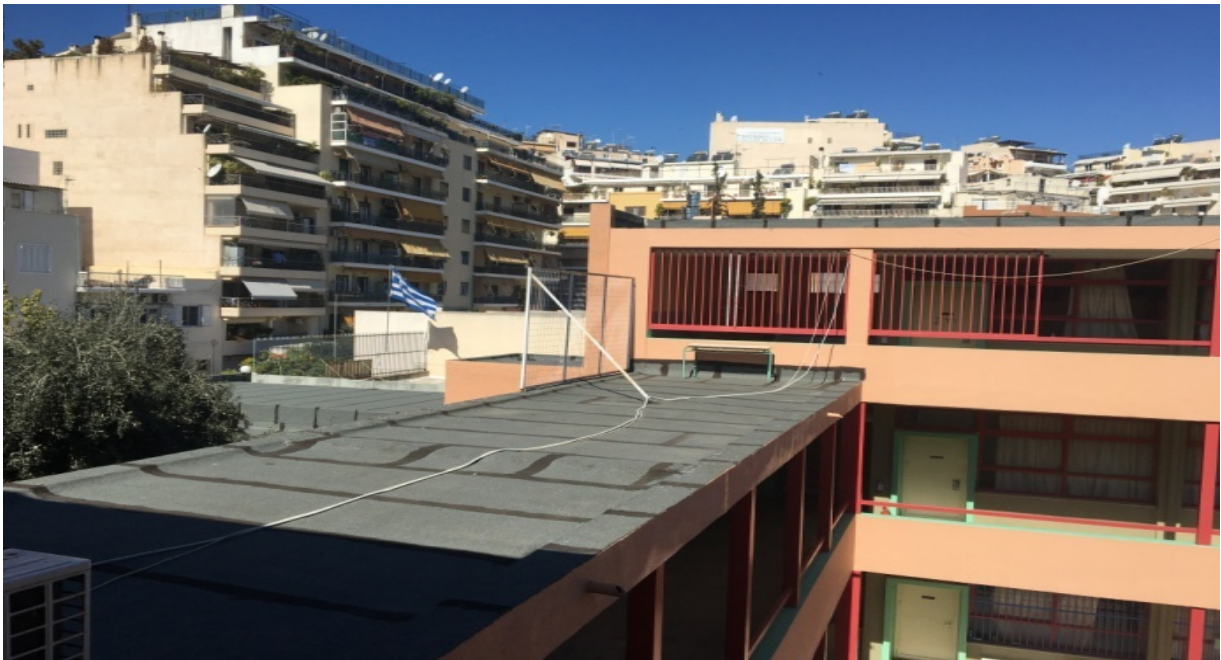
Εικόνα 39 Δώμα μεταξύ των 2 κτηρίων αιθουσών που καλύπτεται από ασφαλτόπανο
