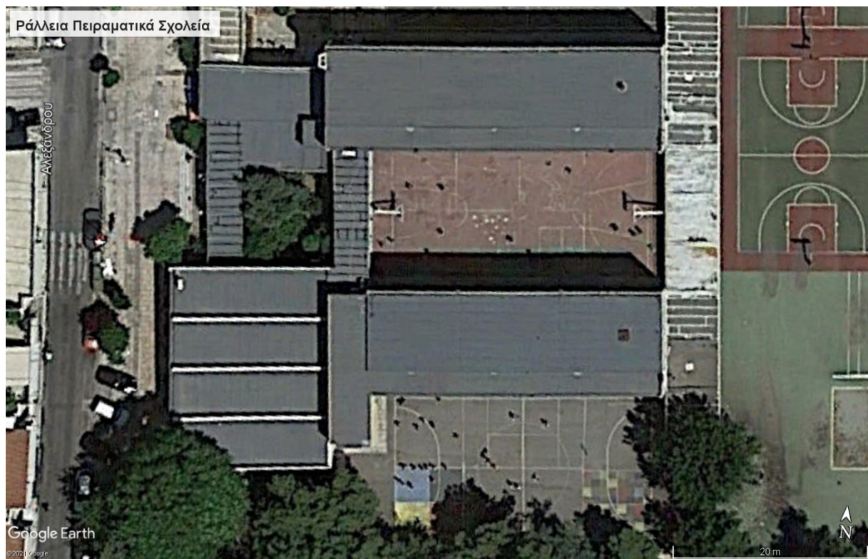
Εικόνα 46 Η τωρινή κατάσταση στο σχολείο-Baseline Scenario (Google Earth)
