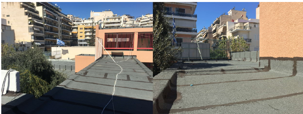
Εικόνα 28 Τα ασφαλτόπανα στα δώματα του σχολείου
