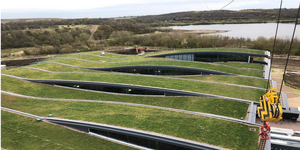
Εικόνα 17 Φυτεμένα δώματα σε κτήριο στην Αγγλία (Skelton Lake Motorway Service Area project in Leeds) (Geogreen, 2021)
